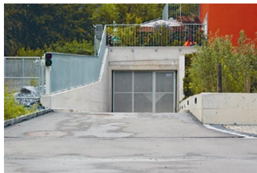
Leicht angehobene Tiefgarageneinfahrt als Objektschutzmassnahme in Zürich-Affoltern.
