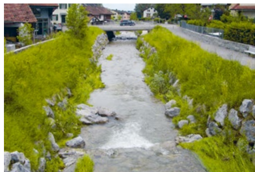
Früher wurden Gewässer oft begradigt und kanalisiert. Auch heute kommen Verbauungen zur Anwendung, sie müssen jedoch hohen ökologischen Anforderungen genügen (Chämpfnerbach, Wetzikon, 2008).
