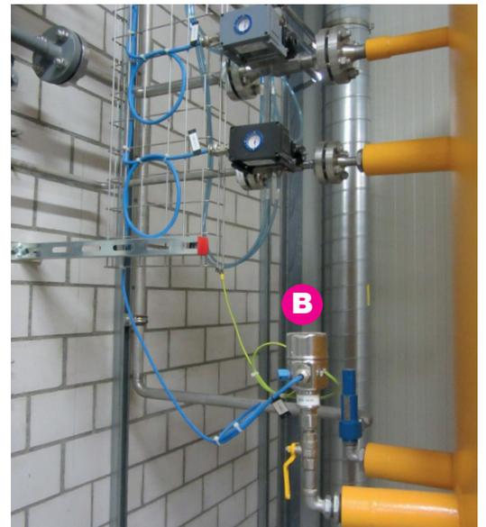
**B** – Schlechtes Beispiel: Die Anschlüsse an den Gasdrucktank sollten nicht starr, sondern flexibel ausgeführt werden, damit sie im Ereignisfall nicht abreißen. (© Basler & Hofmann)
