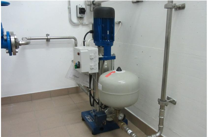
Gutes Beispiel: Die Rohrleitungen sind auf Stahlkonsolen aufgelegt, die an der Betonwand verankert und in Rohrleitungsrichtung teilweise mit Streben horizontal ausgesteift sind.
