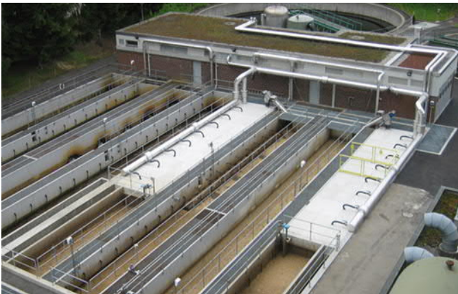
Abb. 2: ARA mit Belebtschlamm-Verfahren in Kombination mit Membran-Bioreaktoren.
