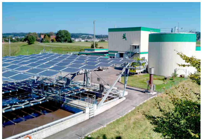
Abb. 19: Das 2020 in Betrieb genommen Solarfaltdach der ARA Bassersdorf soll gemäss Prognose den Eigenversorgungsgrad beim Strom von 38 auf 60 % steigern.
