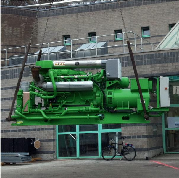
Das BHKW der ARA Winterthur-Hard ermöglicht eine Eigenversorgung > 75 %. Bei der Neuanschaffung wurde auf eine optimale Auslegung (Nennlastbetrieb), den Einsatz moderner Abgasreinigungsverfahren und der vollständigen Abwärmenutzung geachtet. (©Roger Müller)
