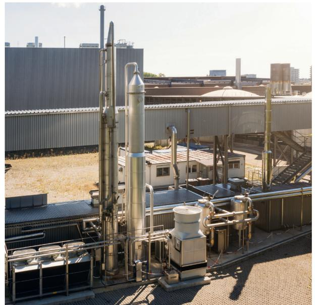
Klärgasaufbereitungsanlage auf dem Areal der ARA Werdhölzli. Die Aufbereitung dient der späteren Einspeisung ins Gasnetz. (©Biogas Zürich AG)
