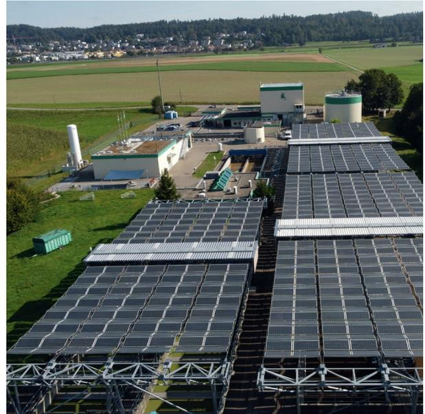
Die ARA als Energielieferant. Der Strombedarf der Biologie und der Ozonung kann auf der ARA Bassersdorf mittels Solarfaltdach und Klärgasverstromung kompensiert werden.
