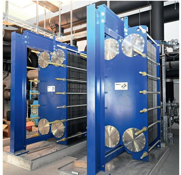
Erweiterbarer Wärmetauscher für gereinigtes Abwasser. In Kombination mit einer Wärmepumpe kann so das grösste energetische Potenzial einer ARA erschlossen werden. (©ERZ Entsorgung + Recycling Zürich)
