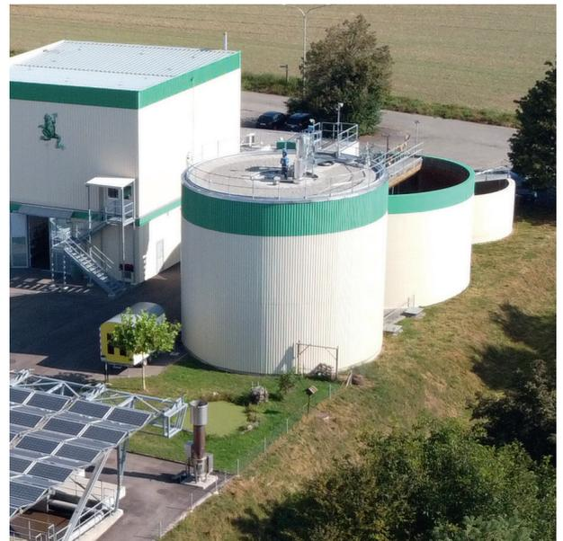
Die Faulung ist für die Energiebilanz einer ARA von zentraler Bedeutung: Aus Klärschlamm kann so Klärgas gewonnen werden. Auf dem Bild ist neben dem Faulturm ebenfalls die Fackel der ARA Basserdorf ersichtlich.
