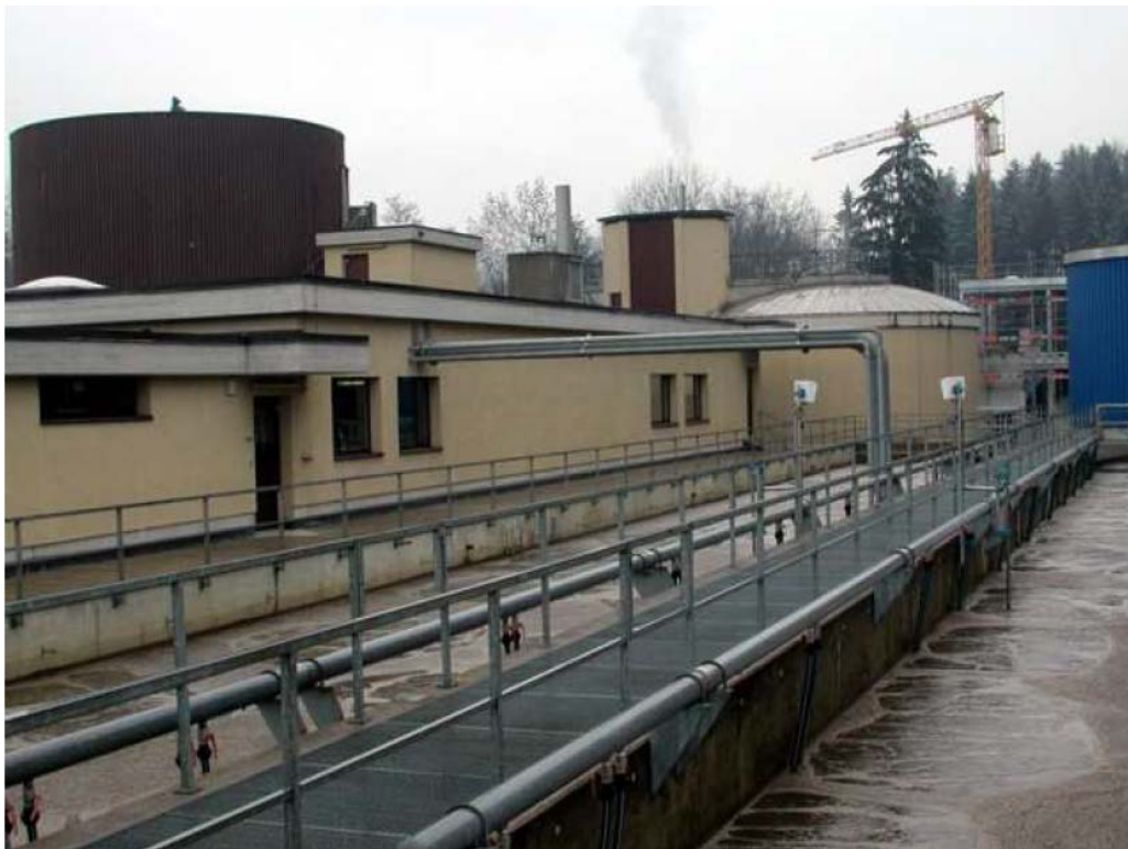
Abbildung 22: Aussenansicht der ARA Affoltern-Zwillikon.
