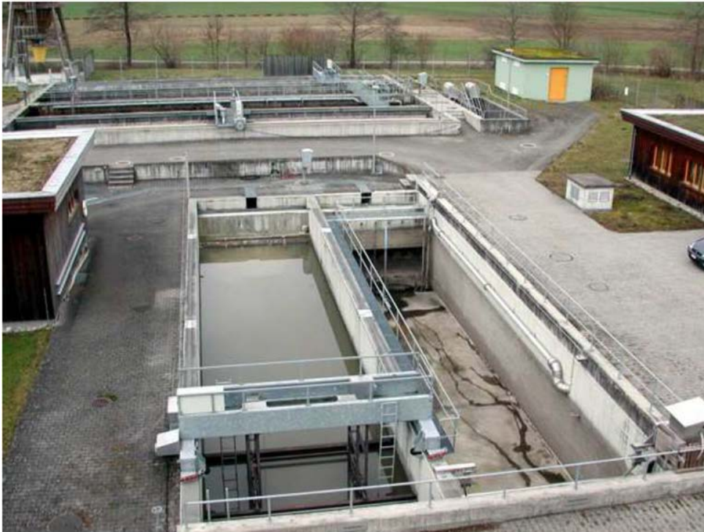
Abbildung 23: Aussenansicht der ARA Hausen.
