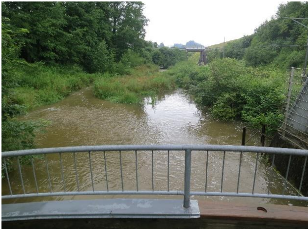
Abbildung 13: Stampfweiher, Blick aufwärts; rechts im Bild ist die Wasserfassung
