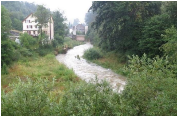
Abbildung 15: Blick von oben in Fließrichtung zum Wehr im Hintergrund (Stauraum abgesenkt)
