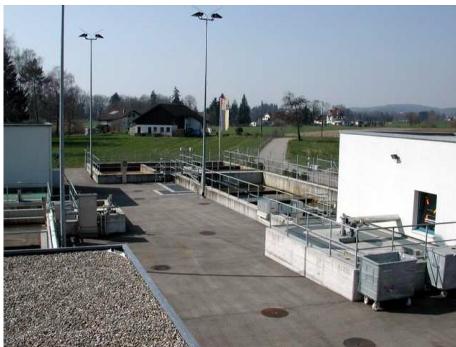
Abbildung 44: Aussenansicht der ARA Bubikon-Wolfhausen [24].
