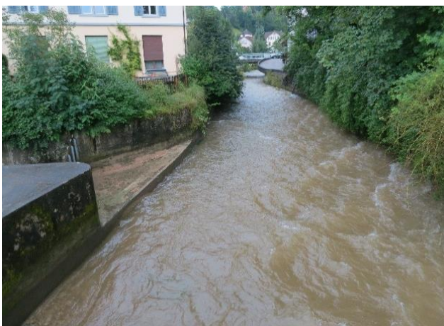
Abbildung 14: Einlauf Oberkanal, die Erhöhung des Einlaufs ist sichtbar, da das Wehr bei Hochwasser offen ist.
