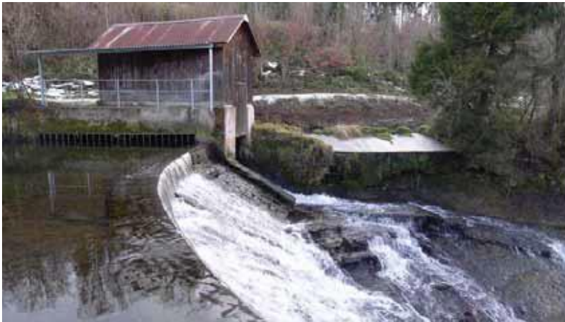
Abbildung 17: Stauwehr der Wasserkraftanlage Brändlin [7]
