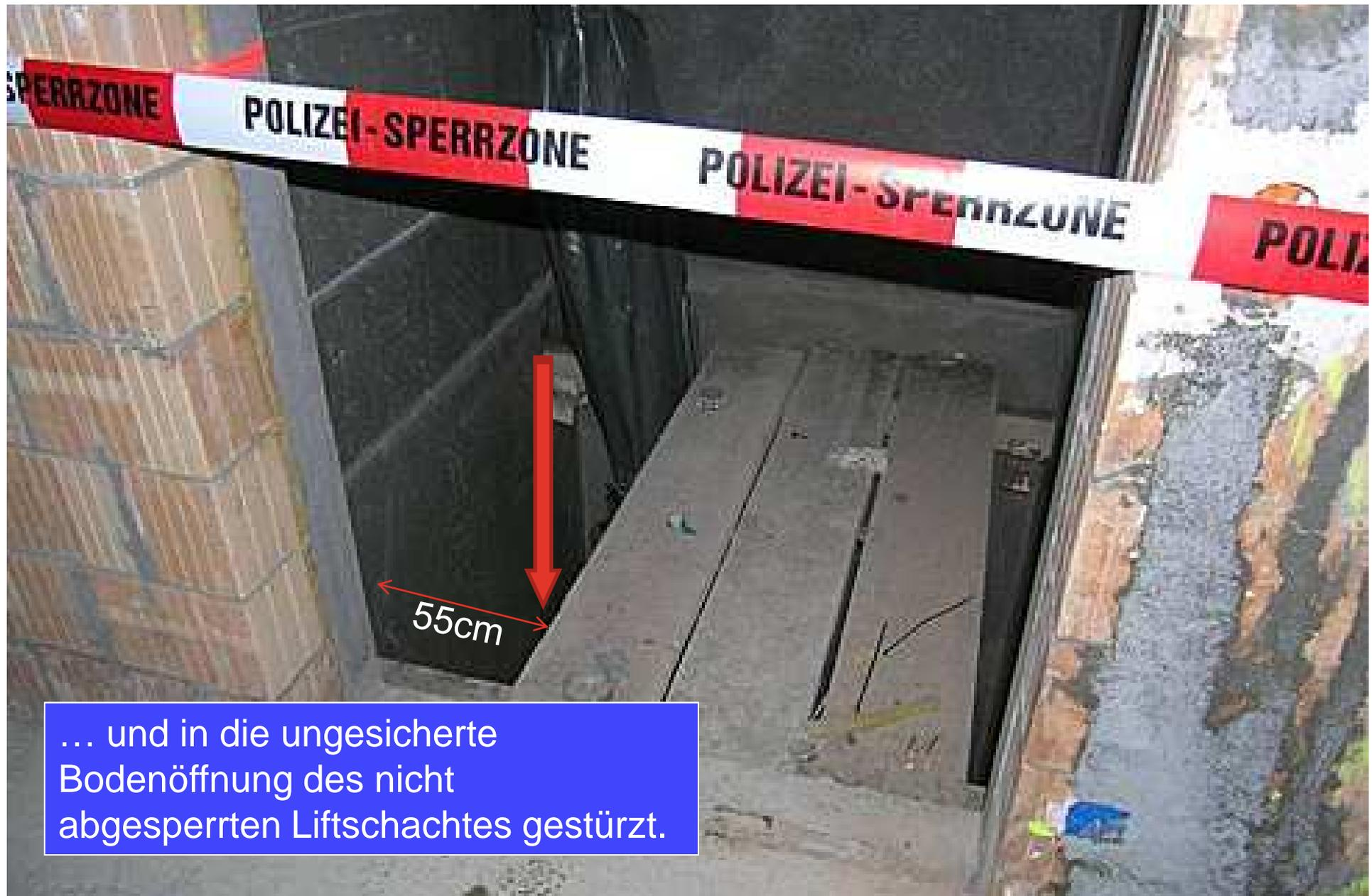
... und in die ungesicherte Bodenöffnung des nicht abgesperrten Liftschachtes gestürzt.
