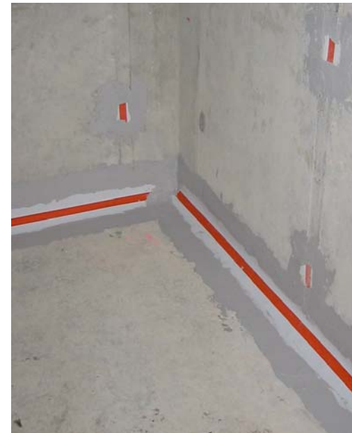
abgedichtet mit Combiflex
