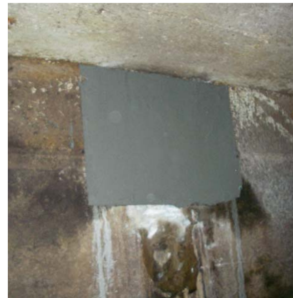
Aussparung zugemörtelt
