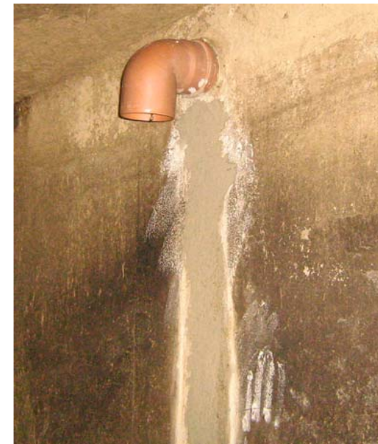
Einlauf zugemörtelt und verlängert mit Bogen
