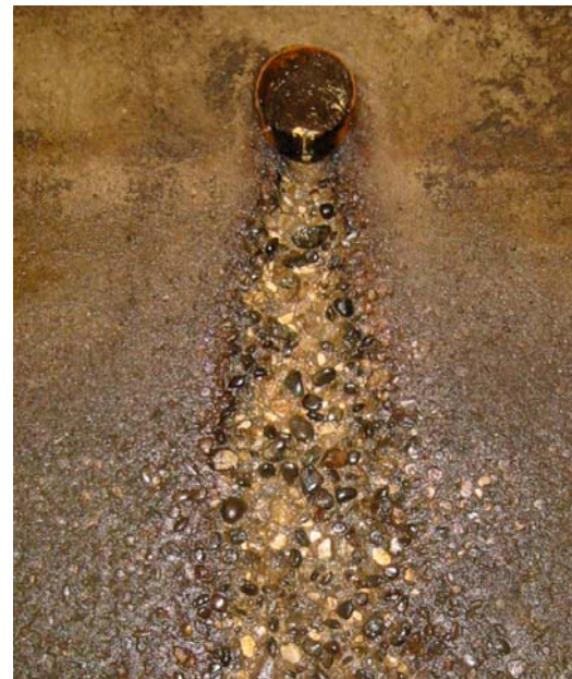
„ausgefressener“ Beton
