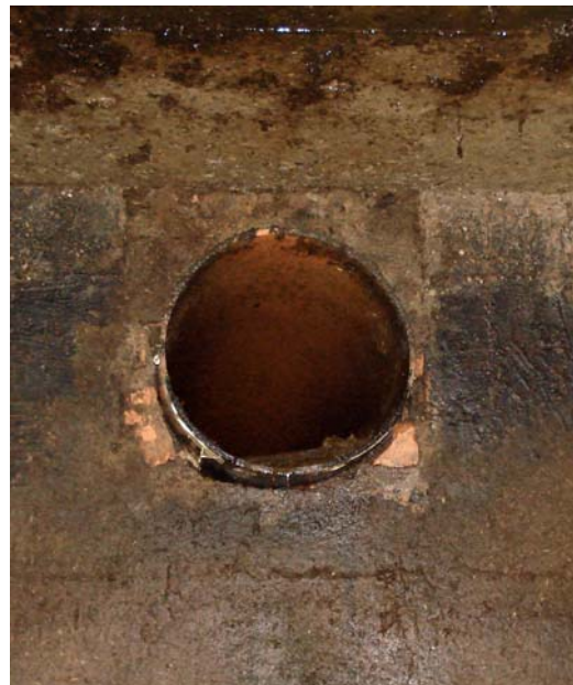
nachträglich erstellter Einlauf
