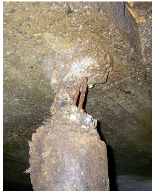
„eingeschränkte“ Tragfähigkeit einer Stütze
