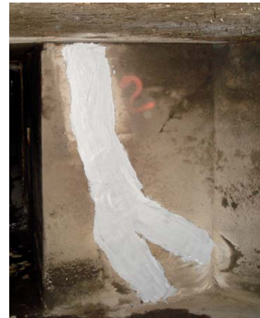
abgedichtet mit Combiflex
