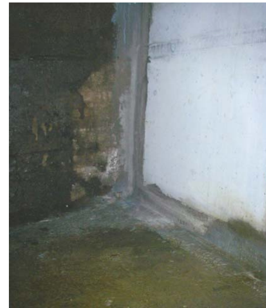
neue vorbetonierte Wand (Sanierungsvariante)
