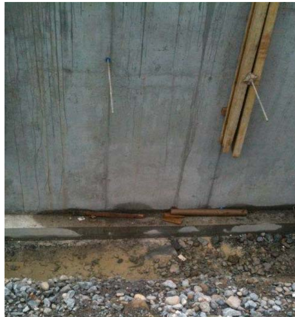
undichte Arbeitsfuge
