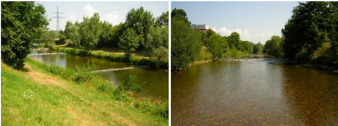
Abbildung 8: Ausgebaute Wiese in Lörrach mit Doppeltrapezprofil, regelmässigen Schwellen und verflachter Sohle (Fotos: M. Mende)
