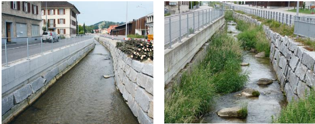
Abbildung 9: Enziwigger in Willisau links 2009 vor Massnahmen und rechts 2013 nach dem Einbau von Blöcken und Faschinen. Zusammen mit dem randlichen Bewuchs hat sich eine grössere Strömungsvielfalt und ein konzentrierterer Abfluss eingestellt (Fotos: Kanton Zürich, vif, Abteilung Naturgefahren)
