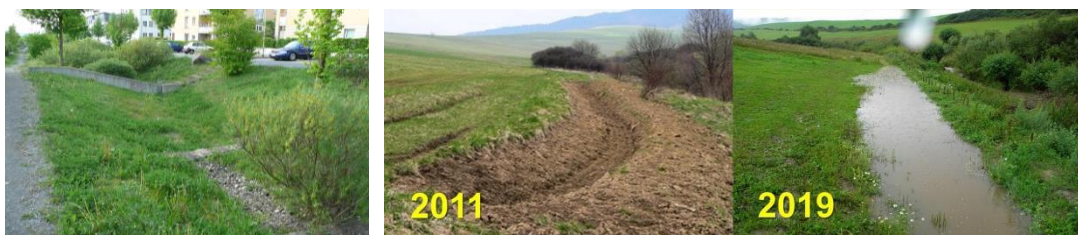
Abbildung 10: Versickerungssysteme. Links: Mulden-Rigolensystem im Siedlungsgebiet (Quelle: Wikipedia); rechts: Hangparallele Geländemulde im Landwirtschaftsgebiet (Fotos: Michal Kravcik)
