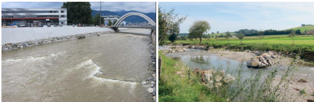
Abbildung 51: Überströmte Lenkbuhnen zur Induzierung eines Niederwassergerinnes in der Kleinen Emme LU (links, Foto: L. Meier). Umströmte Blockbuhnen in der Tulln / Niederösterreich (rechts; Foto: EZB TB Zauner)
