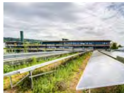
Kombination von Solaranlagen und Dachbegrünung (ewz-Unterwerk Oerlikon). Quelle: ewz
