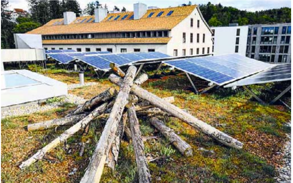
Das ideale Gründach: Solaranlage, Kleinstrukturen und ökologische Begrünung werden kombiniert (Greencity). Quelle: GSZ
