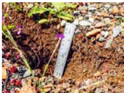
Mindestens zehn Zentimeter (verdichtetes) Qualitätssubstrat. Quelle: GSZ
