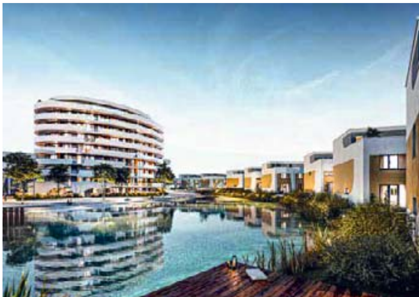
Regenwasser wird in der Überbauung «Arkadien Dornstadt» künftig im zentralen See sowie einer Zisterne gesammelt werden (nächste Seite). Quelle: Strenger Gruppe
