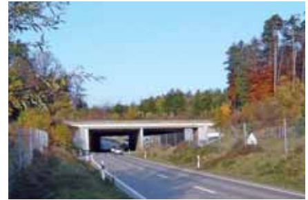
Die beiden Überführungen Rütibuck (oben) und Loterbuck (unten) sollen helfen, die Barrierewirkung von Strassen zu reduzieren.
