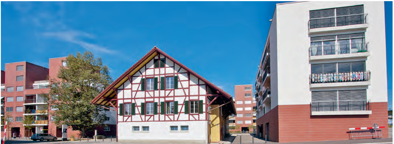
Der Begriff Siedlungsqualität ist nicht abschliessend definierbar. Er umfasst verschiedene Themen wie Sicherheit, Einkaufsmöglichkeiten, Immissionen, soziale Zusammensetzung, aber auch bauliche Qualitäten. Im Bild: Zwicky-Areal.
