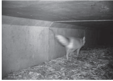
Kleintiere wie dieser Fuchs durchqueren Kleintierdurchgänge. Quelle: B+S AG
