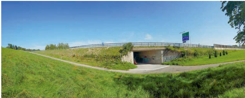
Naturbelag, zusätzliche Büsche und mehr nutzbare Böschung ermöglichen Wildtieren wie Reh, Marderartigen und anderen Kleintieren bei der Unterführung Hasenacker auf die andere Seite der A52 zu gelangen. Quelle: TBA
