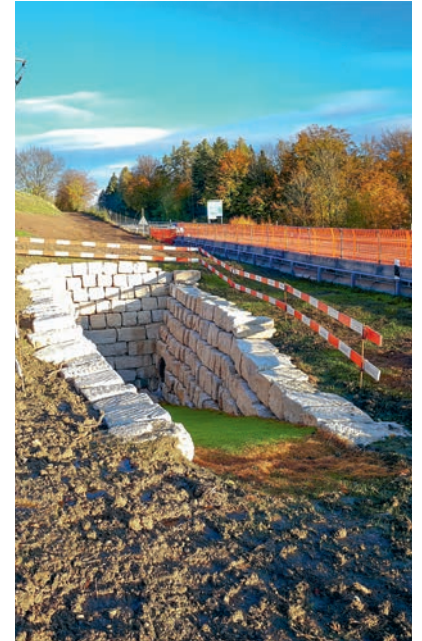
Der neu erstellte Kleintierdurchgang Heuberg ermöglicht Füchsen, Marderartigen und anderen Kleintieren ohne Gefährdung die A52 zu unterqueren. Quelle: TBA
