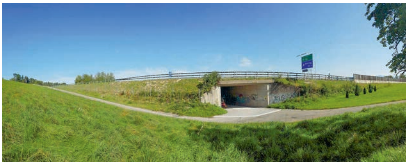
Naturbelag, zusätzliche Büsche und mehr nutzbare Böschung ermöglichen Wildtieren wie Reh, Marderartigen und anderen Kleintieren bei der Unterführung Hasenacker auf die andere Seite der A52 zu gelangen. Quelle: TBA
