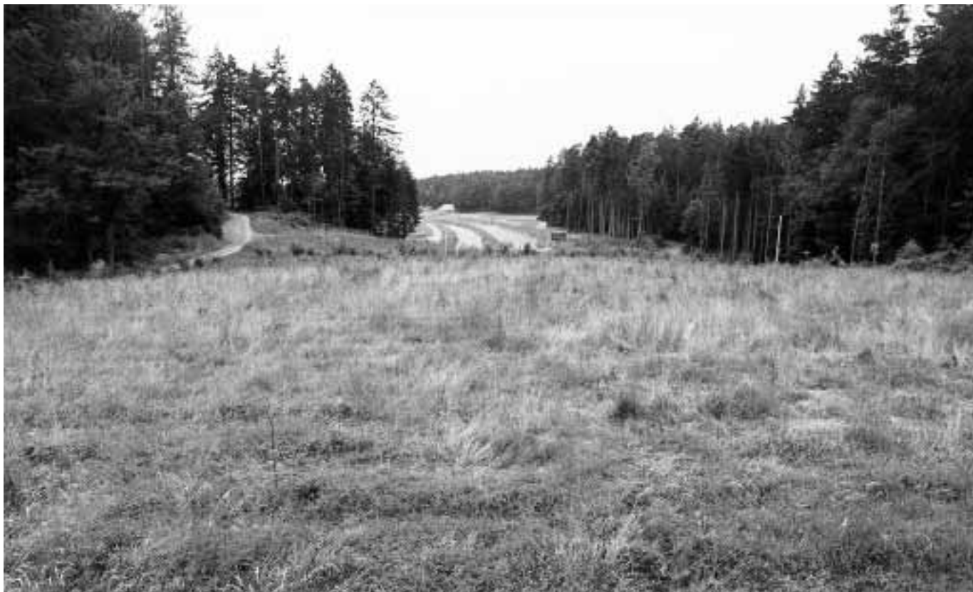
Sind die Bäume und Büsche einmal hoch gewachsen, wird der Verkehr rechts und links der Brücke nicht mehr zu sehen sein. Dann ist die Landschaft in die Brücke hinein gewachsen.
