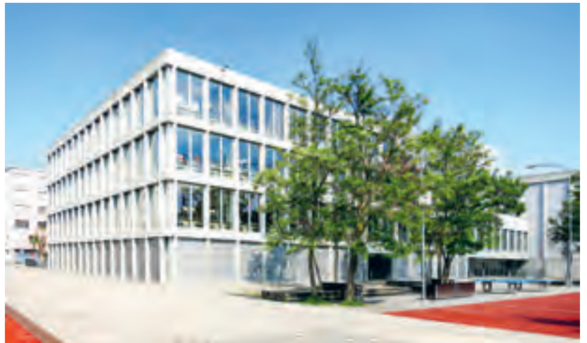
Mit dem 2004 eingeweihten Schulhaus «Im Birch» betrat die Stadt Zürich Neuland: Erstmals kam Recyclingbeton für alle vor Ort gegossene Bauteile zum Einsatz.
