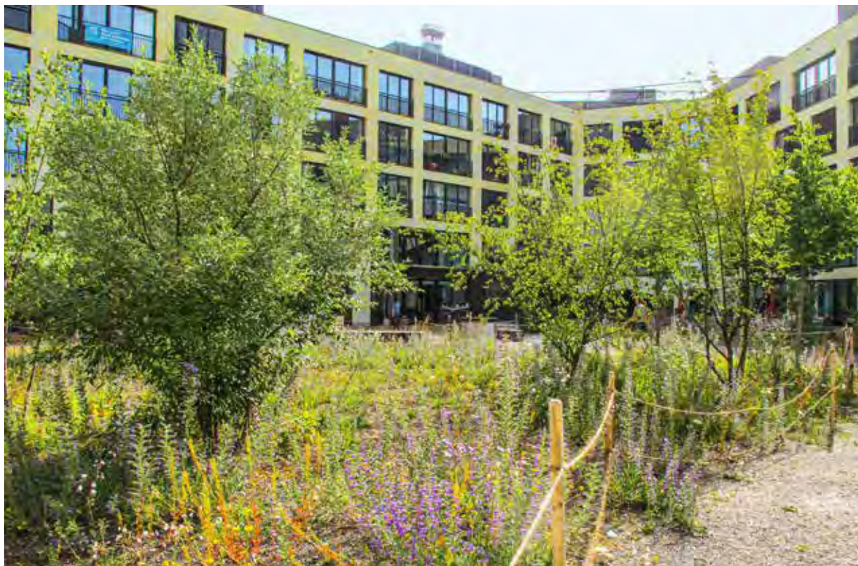
Gut gestaltete Dachflächen können sowohl begrünt als auch genutzt werden und ergänzen als Dachgärten den knapper werdenden Freiraum (Kalkbreite).
