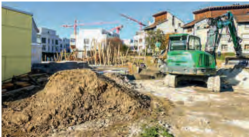
Die Gemeinde Jonschwil-Schwarzenbach nutzte den Bau des neuen Primarschulhauses, um das ganze Areal naturnah aufzuwerten.
