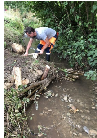
Eine Dreiecksbuhne, geformt aus zwei Faschinen, lenkt hier die Strömung. Quelle: Pusch
