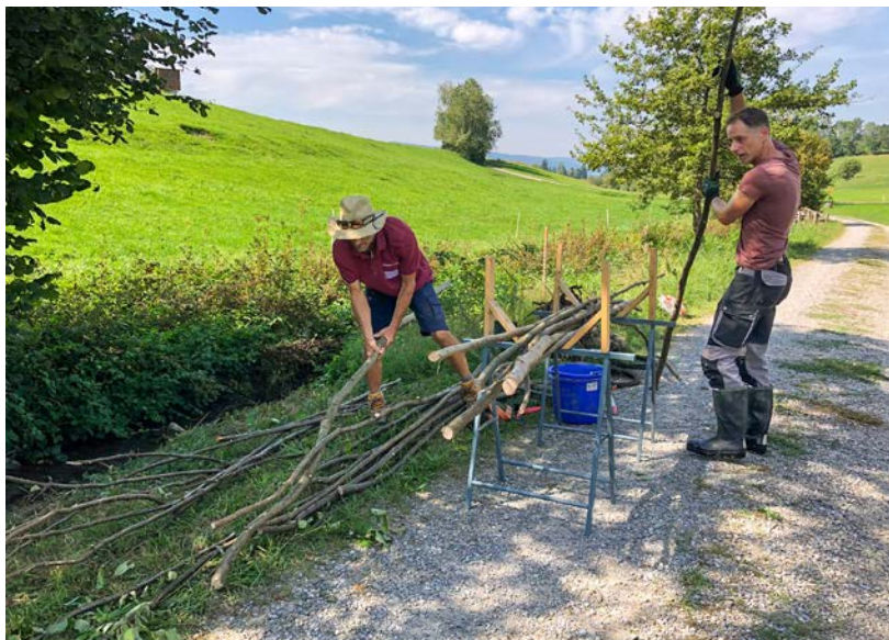
Aus Rutenbündeln eine Faschine zu konstruieren, ist Handarbeit und will gelernt sein. Quelle: Pusch
