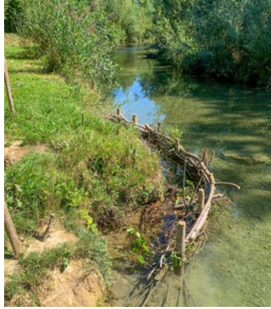
Ein Flechtzaun mit «Hinterwasser». Quelle: Andreas Nagel
