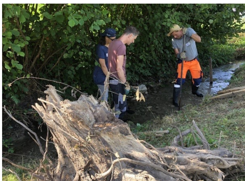
Kursteilnehmende bauen zur Belebung des Wüeribachs einen Wurzelstock ein. Quelle: Pusch
