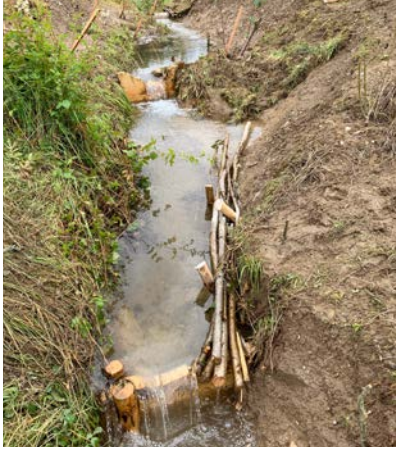
Mit einer Fashine lässt sich die Uferpartie befestigen. Quelle: Andreas Nagel
