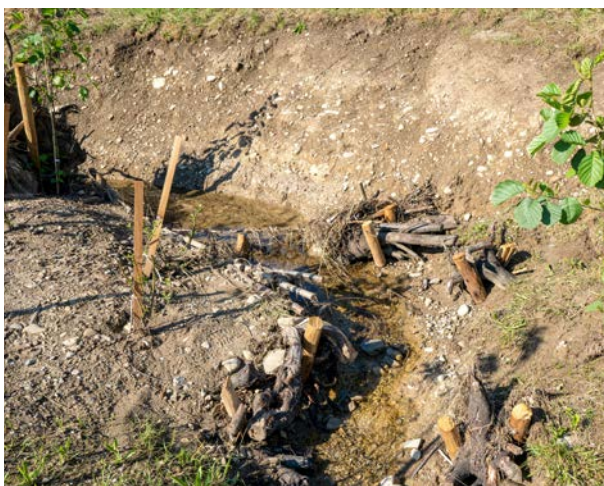
Bäume werden zu lebenden Bauelementen. Die frisch gepflanzte Schwarzerle im Bild soll künftig mit ihren Wurzeln die leichte Böschung stabilisieren. Quelle: Pascal Sieber
