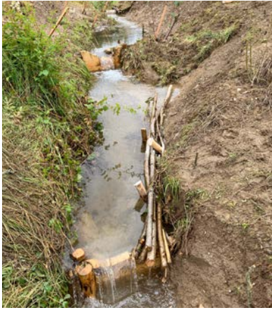
Mit einer Faschine lässt sich die Uferpartie befestigen. Quelle: Andreas Nagel
