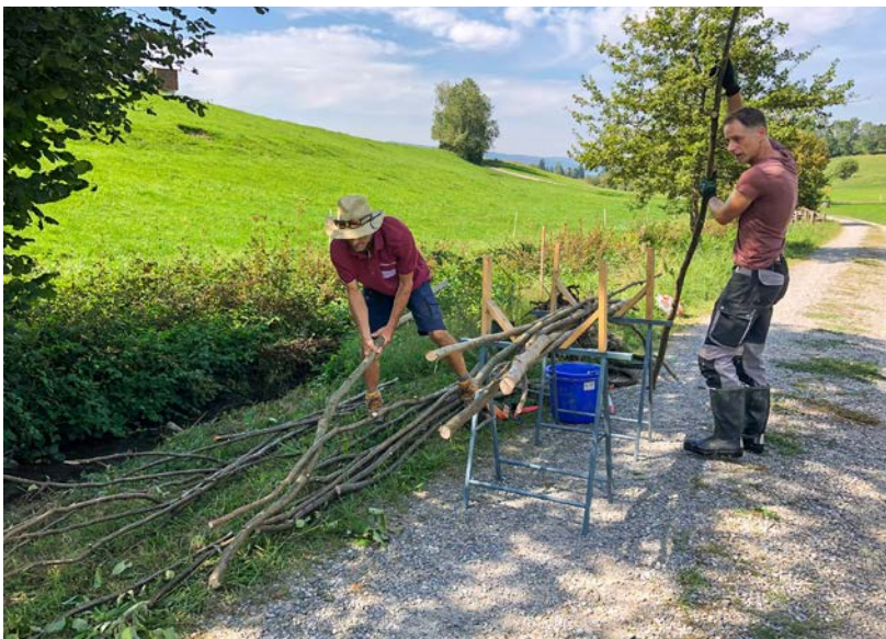
Aus Rutenbündeln eine Faschine zu konstruieren, ist Handarbeit und will gelernt sein. Quelle: Pusch
