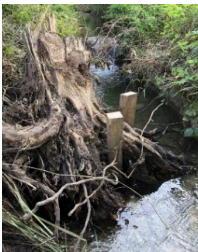
Ein mit Pfählen verankerter Wurzelstock im Wüeribach. Quelle: Pusch
