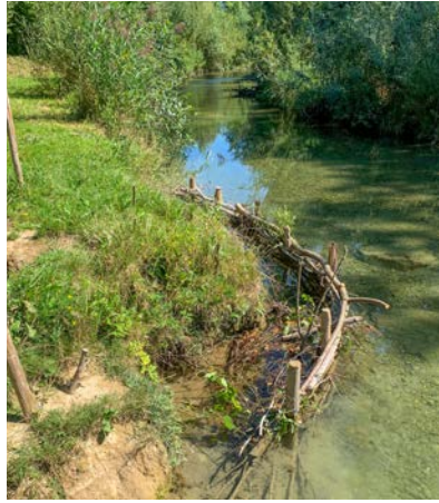
Ein Flechtzaun mit «Hinterwasser». Quelle: Andreas Nagel
