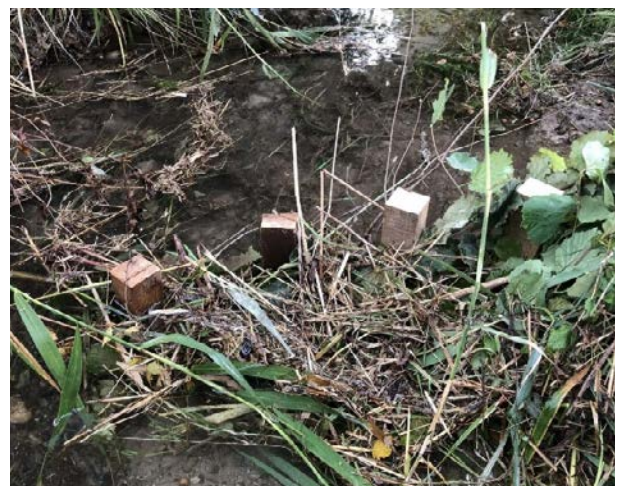
Eine Pfahlreihe mit angeschwemmtem Material verändert Strömungsverhältnisse und bietet Verstecke. Quelle: Pusch
