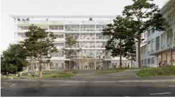
Kantonale Neubauten werden im Minergie-P-Eco- oder Minergie-A-Eco-Standard erstellt, und es wird auch beim Bau auf die Minimierung der Treibhausgasemissionen geachtet, wie zum Beispiel beim geplanten Zentrum für Zahnmedizin. Quelle: ARGE Boltshauser Architekten AG / Drees & Sommer Schweiz AG, Zürich.
