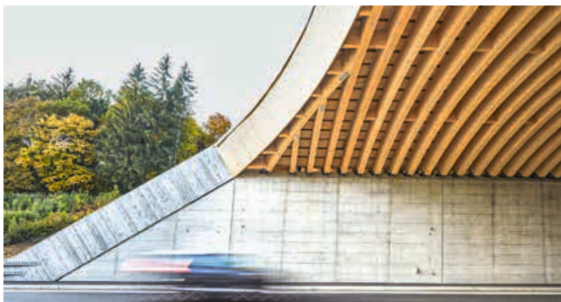
Die erste Schweizer Wildtierbrücke aus Holz führt zwischen Gränichen und Suhr über die Autobahn A1. Quelle: Timbatec, Nils Sandmeier
