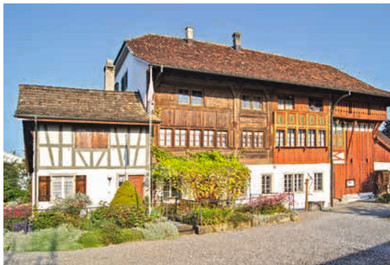
Antike Möbel und Fachwerkhäuser sind Beispiele dafür, wie lange Holz in Verwendung bleiben kann: Im Haus zur Farb in Stäfa etwa ist ein Teil des Holzes rund 560 Jahre alt. Das heutige Ortsmuseum entstand im Kern als Bohlenständerbau um 1460 (Foto rechts).
