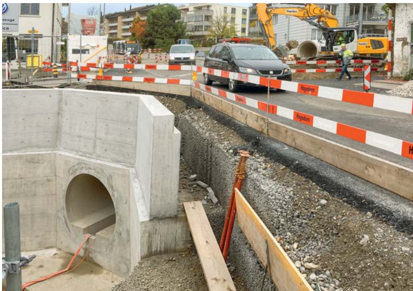
Gemeinden können die Verbindung unterbrochener Lebensräume ebenfalls fördern. Im Foto: Bachdurchlass mit kleintiergängigen Banketten, Aufdorfstrasse, Männedorf. Quelle: I. Flynn
