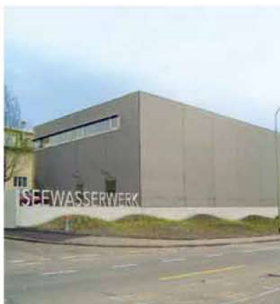
Städte und Gemeinden stellen die Versorgung mit Trinkwasser sicher (Foto: Seewasserwerk Männedorf). Quelle: Osterwalder, Geisser & Brugger AG
