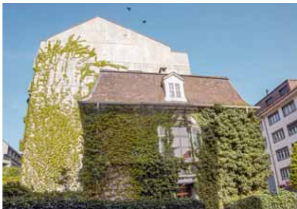
Fassadenbegrünung sowie Hecken können die aggressiv wirkenden hohen Frequenzanteile reduzieren. Quelle: Adrien DeFrance
