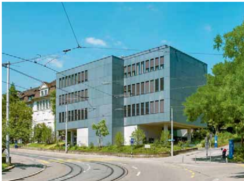
Diese unscheinbare Fassade an der Gloriosastrasse verbirgt eine integrierte Photovoltaikanlage, die erste ihrer Art in einem kantonseigenen Bau. Quelle: Andrea Helbling, Arazebra, Atelier für Fotografie, Zürich
