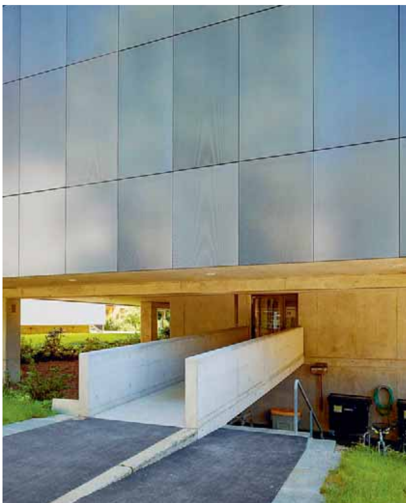
Von nahem wirkt die Fassade fast futuristisch, die Solarmodule werden Teil des Designs. Quelle: Andrea Helbing, Arazebra, Atelier für Fotografie, Zürich
