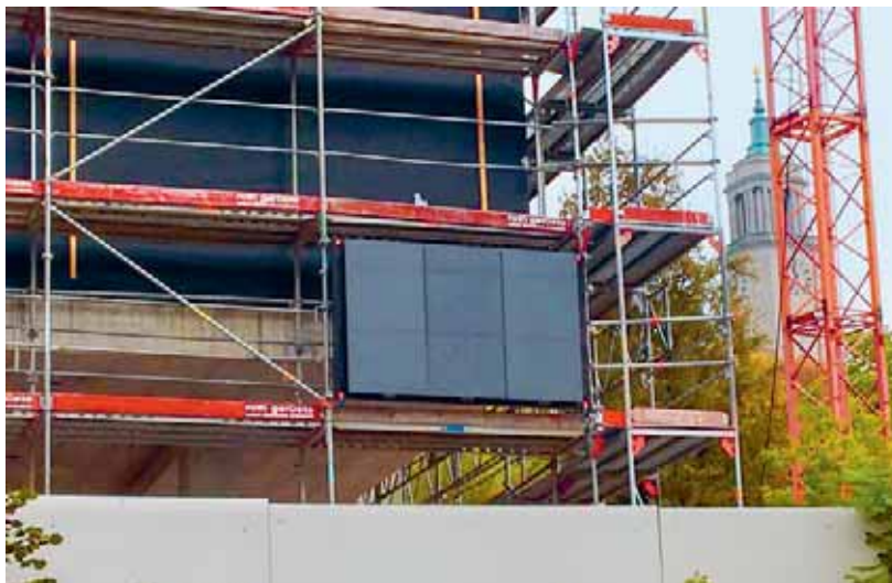
Eine vorgehängte PV-Anlage aus Dünnschichtzellen ist leicht, flexibel und bietet neben energetischen auch bauphysikalische Vorteile. Quelle: HBA
