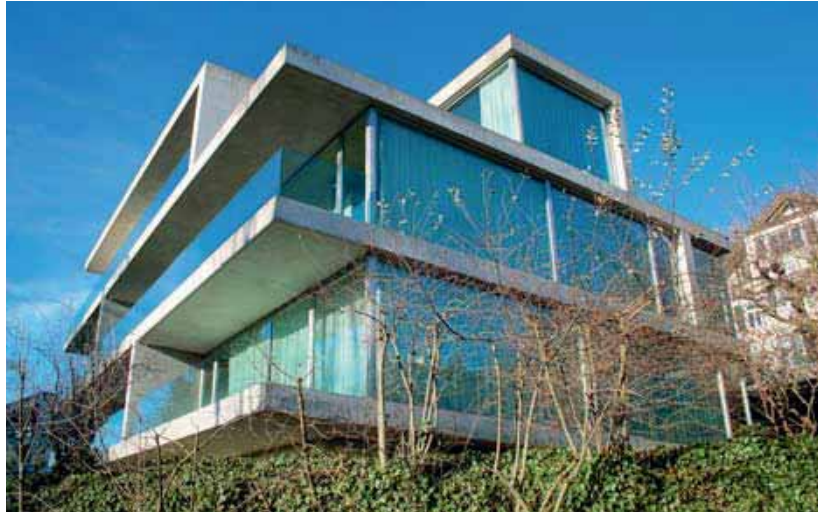
Wohnbauten mit so grossen Glasfronten saugen Sonnenlicht regelrecht ein – ein Problem im Sommer? Quelle: trevor.patt, flickr (CC BY-NC-SA 2.0)
