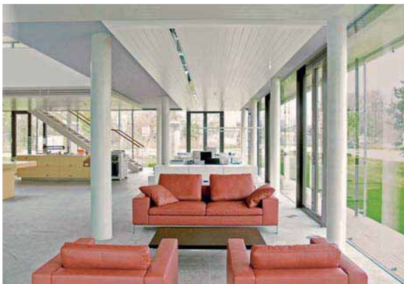
Mit Heiz- und Kühldecken können auch Büros und Eingangsbereiche behaglich temperiert werden.
