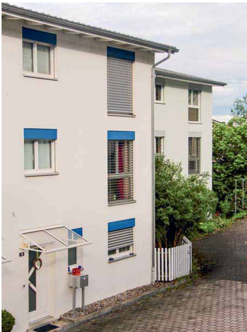
Verschattungen wie diese Lamellenstoren sollen die Sonnenstrahlung gar nicht erst ins Gebäude eindringen lassen.
