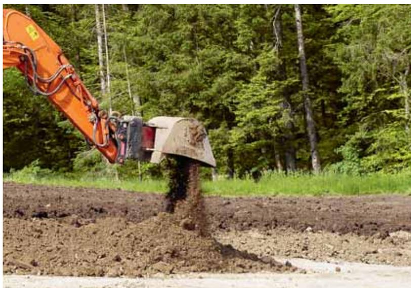
Mit Bodenrekultivierungen können minderwertige Böden zu Fruchtfolgeflächen aufgewertet werden. Dazu werden Ober- und Unterboden fachgerecht über den Untergrund eingebaut.
