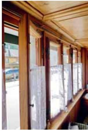
Die Problematik bei der Lärmsanierung dieses Flarzhauses ist komplex: Die Doppelverglasung aus den 1980er Jahren ist in denkmalpflegerischer Hinsicht von untergeordneter Bedeutung und könnte ersetzt werden. Die über einen Seilzug zu bedienenden Falläden hingegen sind wichtige historische Bauzeugen und damit zu erhalten. Schallschutztechnisch problematisch sind hier die Schallbrücken bei den Durchdringungen des Seilzugs.
