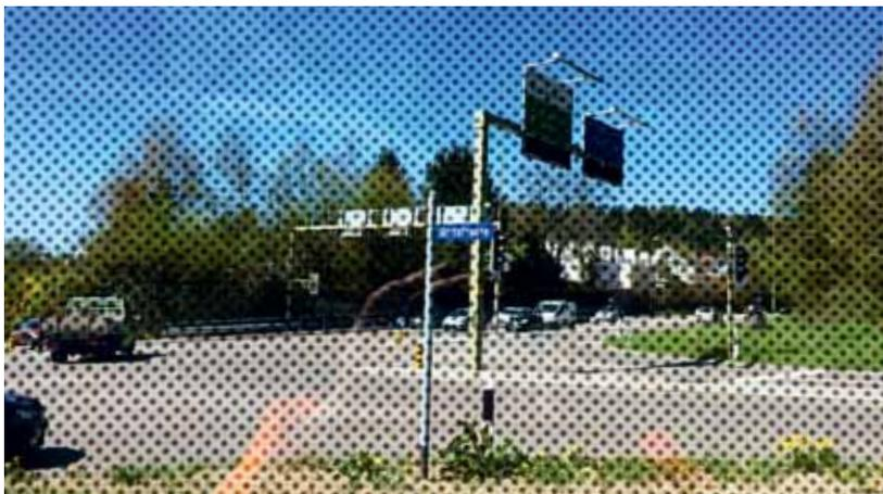
Ein mit der Vogelwarte Sempach abgestimmtes Punkteraster auf dem Glas verhindert, dass die Glaselemente zur Vogelfalle werden.
