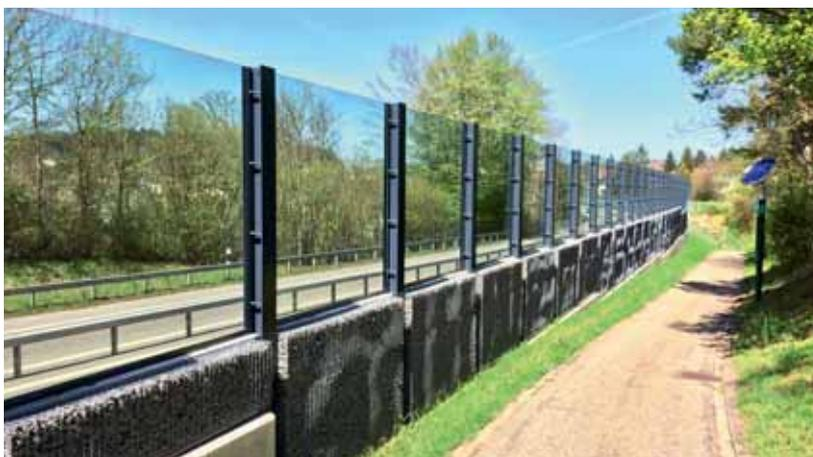
Das Besondere der neu entwickelten Steinkorbelemente: Sie sind dank eines integrierten Lavabeton-Elementkerns schalldicht, aber auch stabil genug, darauf Glaselemente zu montieren.
