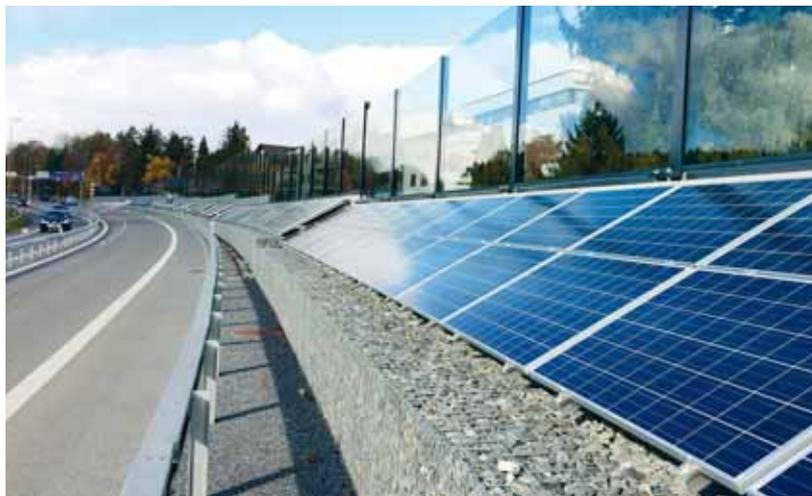
Im Oktober 2014 wurden an der Forchautostrasse in Zumikon auf 300 Metern Lärmschutzwand eine Photovoltaikanlage installiert. Der produzierte Strom kann den Jahresbedarf von 22 Haushalten abdecken.
