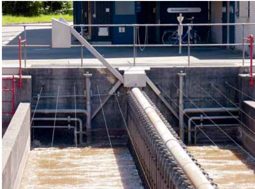
Die Tiere klettern die Rampe hinauf und warten in den Behältern, bis sie eingesammelt und anschliessend wieder ausgesetzt werden. Quelle: Alfred Hofmann
