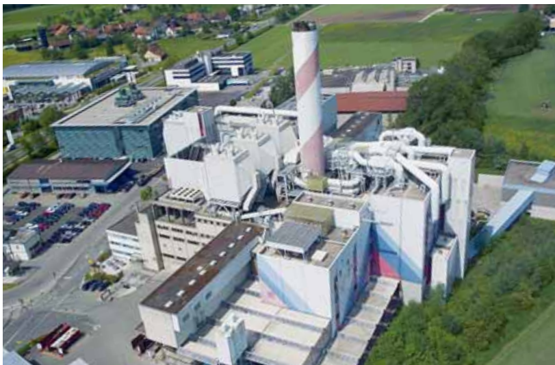
In der KEZO in Hinwil werden Abfälle thermisch verwertet: Die dabei freigesetzte Energie wird als Strom und Wärme verkauft, und die Metalle in der Kehrriechtschlacke werden im hohen Masse zurückgewonnen und wieder als Wertstoffe genutzt. Quelle: Hansjörg Egger, Uster
