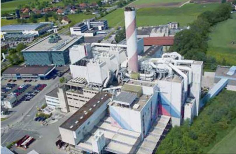
In der KEZO in Hinwil werden Abfälle thermisch verwertet: Die dabei freigesetzte Energie wird als Strom und Wärme verkauft, und die Metalle in der Kehrriechtschlacke werden im hohen Masse zurückgewonnen und wieder als Wertstoffe genutzt.
