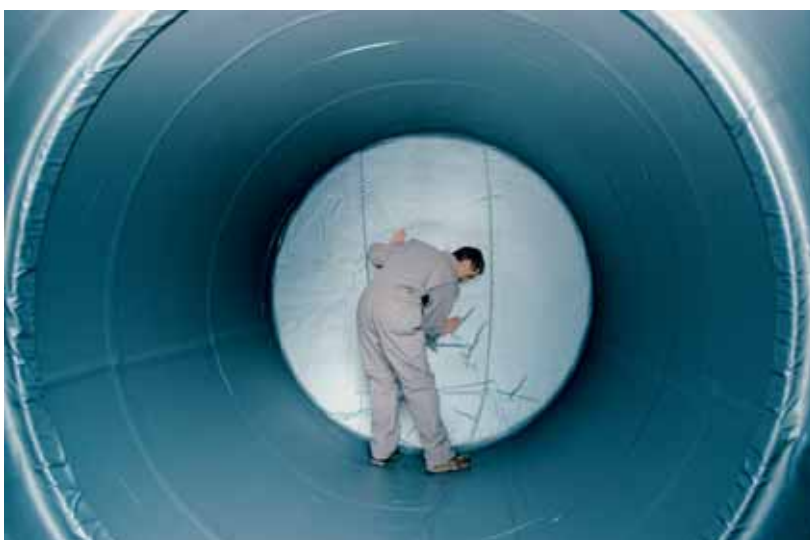
Die Innenfläche des Tanks wird mit einer PVC-Folie ausgekleidet. Quelle: AWEL
