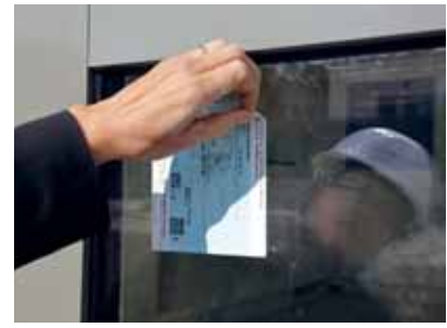
... und kontrollieren die Bauausführung. Quelle aller drei Bilder: AWEL
