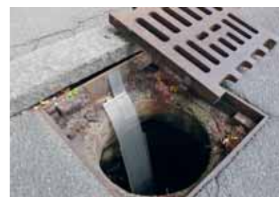
Die Amphibienleiter besteht aus zwei ineinander verschiebbaren Lochblechschienen und einem Ausstiegstück. Quelle: Simon Gaus
