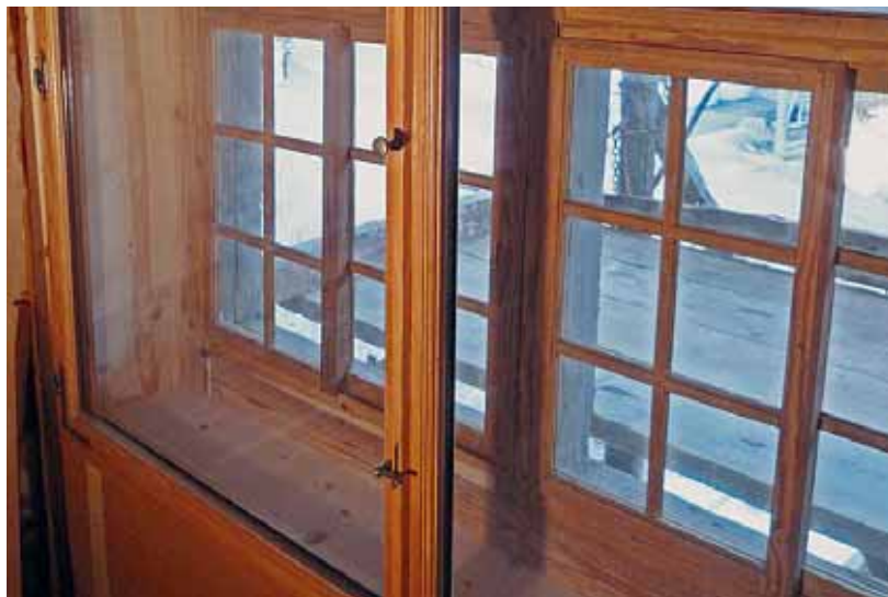
Beispiel für eine energetische Verbesserung ohne Substanzverlust: zusätzliches, inneres Isolationsfenster, das vor dem historischen Schiebefenster installiert wurde (Gossau, Allenwinden).
