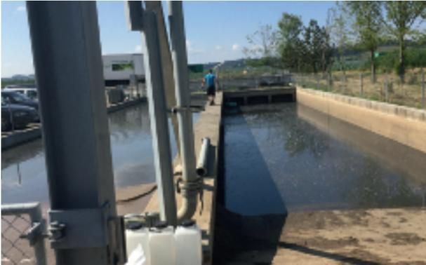
Abb. 11: Auf Schwerkraft beruhende mechanische Trennverfahren (hier: Absetzbecken) sind wartungsarm und langfristig kostengünstig. Sie benötigen aber in der Regel viel Platz, arbeiten je nach Partikelgrösse langsam und können zu Geruchsbelästigungen führen.
