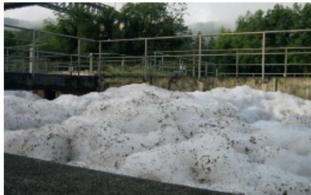
Abb. 9: Totalausfall der biologischen Reinigungsstufe einer ARA nach einem unkontrollierten Ableiten von bierhaltigem Reinigungsabwasser. Es kann Wochen dauern, bis die Mikrobiologie wiederhergestellt ist. In dieser Zeit verschmutzt die ARA die Gewässer besonders stark, da ihre Reinigungsleistung beeinträchtigt ist.
