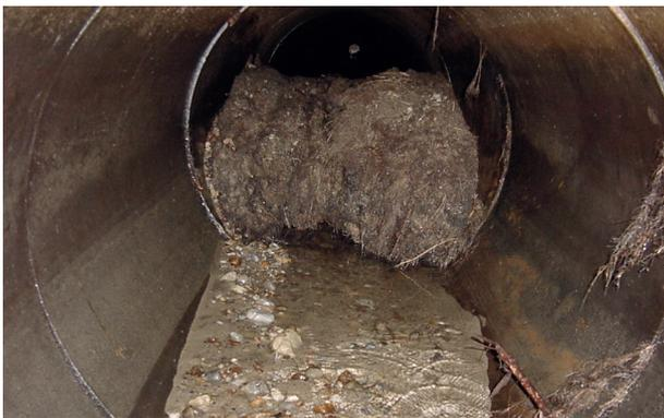
Abb. 17: Abwasserleitungen verlieren mit der Zeit ihre Funktionsfähigkeit, wenn sie nicht regelmässig überprüft und gewartet werden. Hier: Wegen Einwachsungen undicht gewordene Kanalisationsleitung. Quelle: Mökah AG
