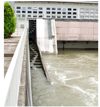
Abb. 6. Bestehender Beckenpass beim Kraftwerk Säckingen
