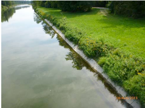
1: Kontrolle: ursprünglicher Zustand mit Vorland (flussaufwärts; 18.8.2013); Abfluss: 9.41m 3 /s
