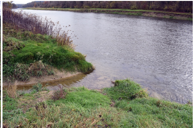
Abb. 3-76: Seit der Maßnahmenumsetzung mündet der Mederbach niveaugleich in die Thur.
