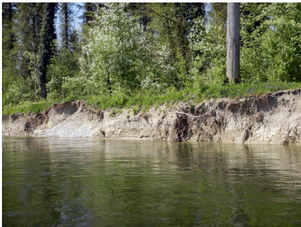
Abb. 3-64: Entlang solcher Abbruchufer bilden sich durch ins Wasser hängendes Wurzelwerk gute Unterstandsstrukturen.
