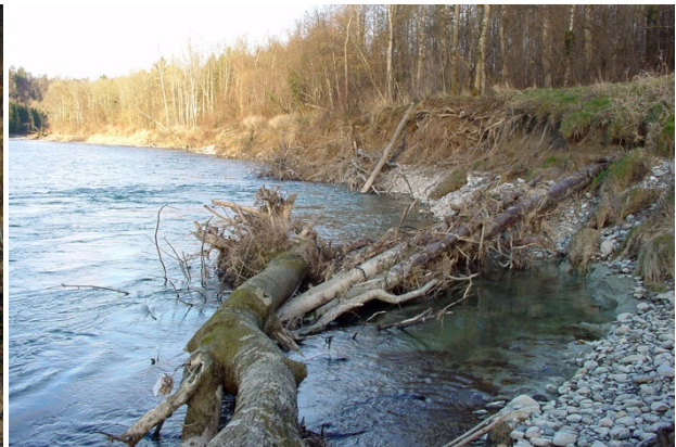
Abb. 3-62: Hier wurden Bäume, die durch die Erosionstätigkeit des Gewässers ins Wasser gefallen sind, zuvor mit Stahlseilen vor Abtrieb gesichert.
