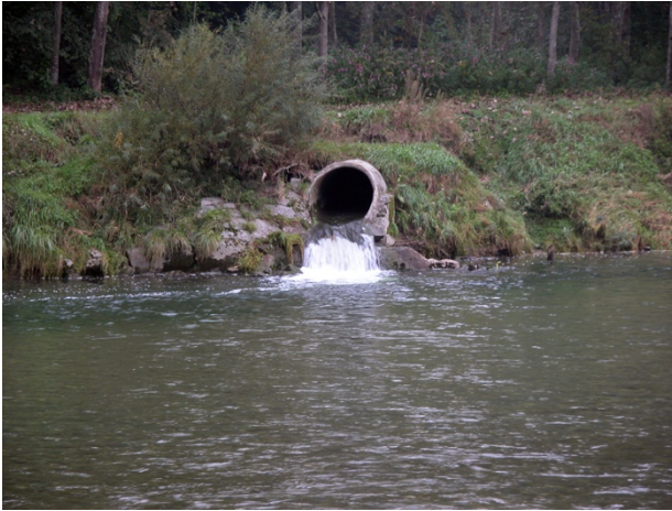
Abb. 3-73: Im Vorzustand mündete der Mederbach über eine Röhre mit anschließendem Absturz in die Thur.
