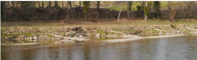
*Abb. 9: Erosionsstellen zwischen den Holzbuhnen in der oberen Tüfenau.*
