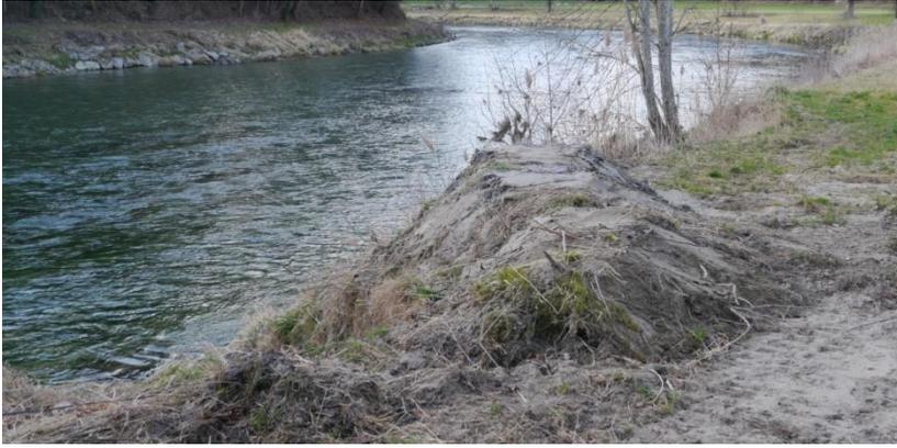
*Abb. 7: Bei „Chlini Au“ wurde das mit dem Bagger abgetragene Erdmaterial oberhalb der Steilwand aufgeschüttet. Dadurch gewinnt das Ufer an Höhe.*
