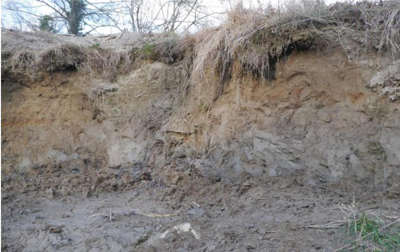
*Abb. 8: Die mit dem Bagger abgetragene Steilwand bei „Chlini Au“ wurde anschliessend mit dem Spaten modelliert und optimiert.*
