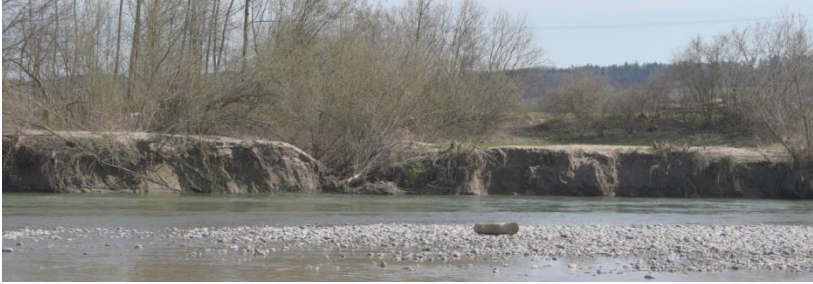
Abb. 46: Die Erosionskante ist gefährdet durch Hochwasser und Störungen. (28.03.2021)
