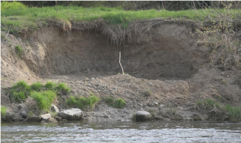
Abb. 40: Die untere der beiden manuell errichteten Steilwände bei Chlini Au weist eine stattliche Grösse auf. (11.04.2021)
