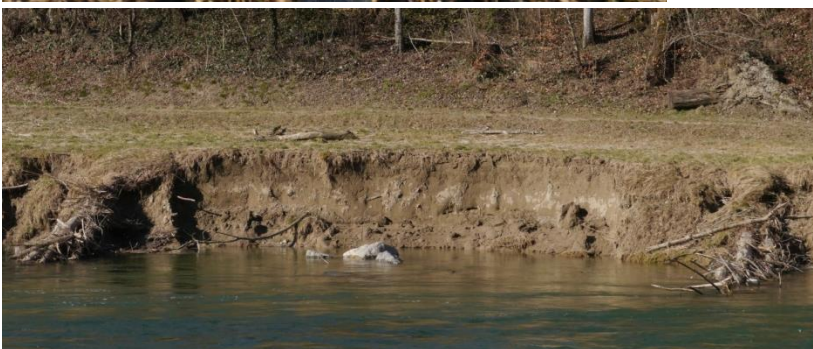
Abb. 9: Erosionsstelle zwischen den Holzbuhnen in der oberen Tüfenau. Dieser potenzielle Brutplatz wurde zu Gunsten des Eisvogels vorerst nicht saniert.
