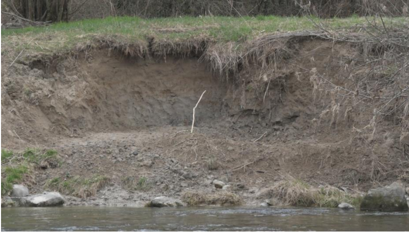
Abb. 7: Mit dem Bagger abgegrabene Steilwand in der Au. Im oberen Bereich wurden mit dem Spaten überhängende Partien geschaffen.
