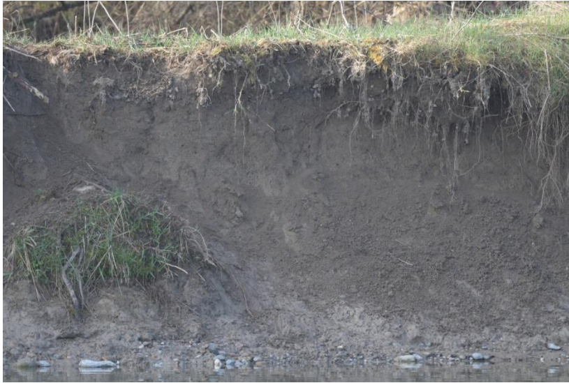
Abb. 10: Das linke Thurufer des Mündungsbereichs ist von einigen überhängenden Steilwänden gesäumt. Auf den regelmässigen Kontrollgängen von März bis August 2021 konnten aber nie Grabspuren oder Höhlen entdeckt werden. (31.03.2021)
