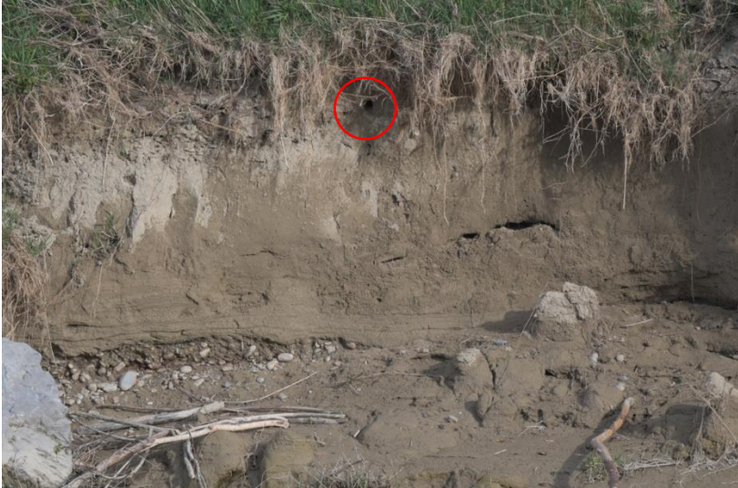
Abb. 43: Die Höhle wird schon bei einem mittleren Hochwasser überspült. (11.04.2021)
