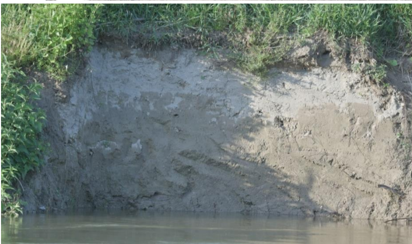
Abb. 6: Eine der beiden mit dem Bagger errichteten Steilwände in den Grueben – hier bei normalem Wasserstand. Bei einem mittleren Hochwasserstand wird der obere Bereich bereits überspült.
