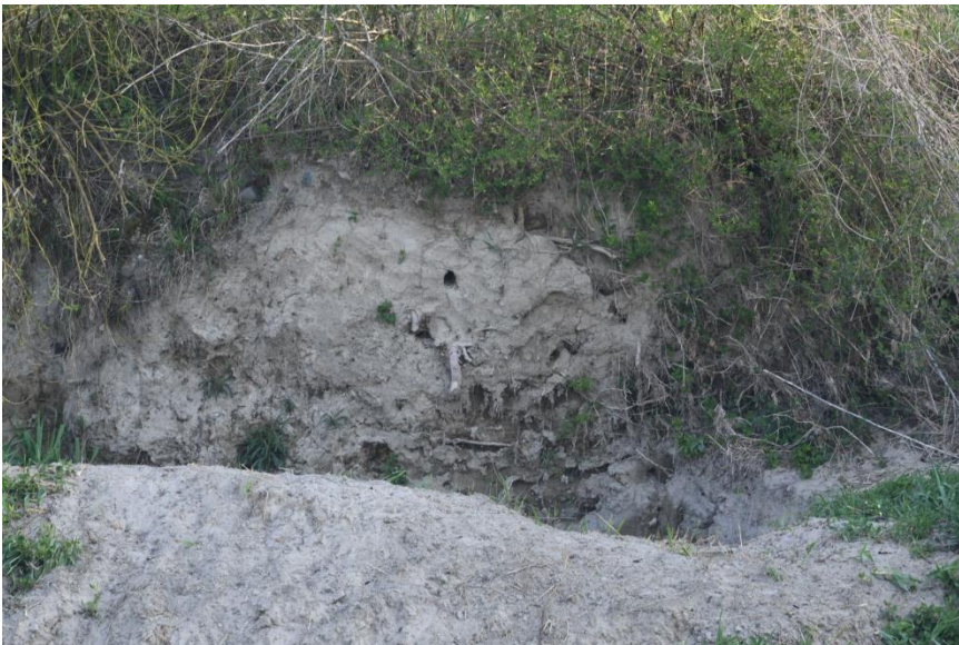
Abb. 6: Instand gestellte Steilwand in den Grueben. Diese Massnahme wurde mit dem Bagger ausgeführt. Vor der Wand blieb jedoch ein Erdwall bestehen.
