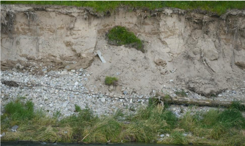
Abb. 61: Durch die anhaltenden Niederschläge brach die Wand einige Tage nach dem Hochwasser dann doch noch auf der ganzen Höhe ab und riss auch die Höhlen mit.
