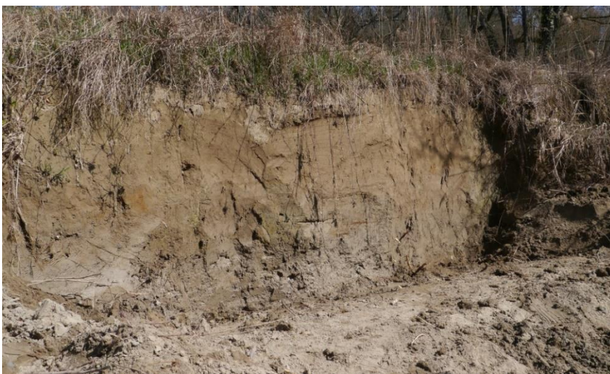
Abb. 8: In der Au wurde eine steile Böschung am 18. März zum zweiten Mal mit dem Bagger abgegraben.
