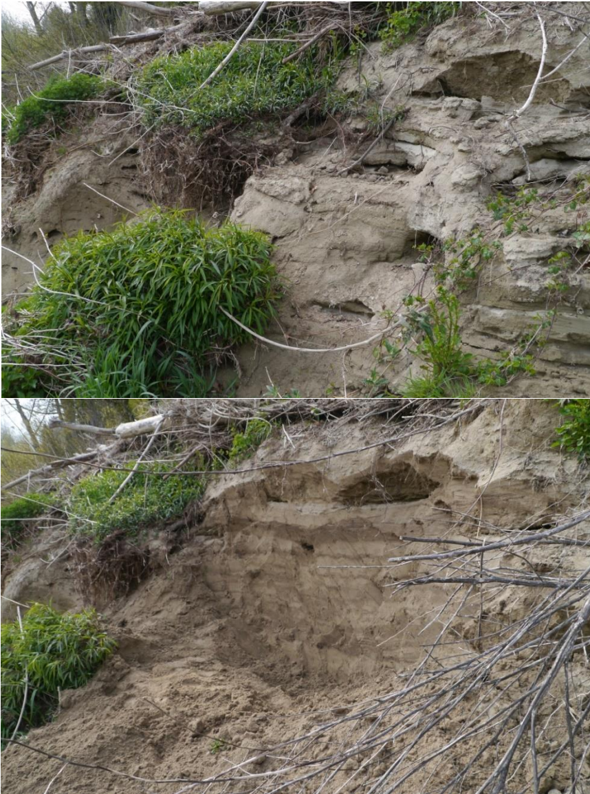
Abb. 9: In der Tüfenau wurde gegenüber dem Thurhof im April diese steile Uferböschung mit dem Spaten abgestochen. Das Bild unten zeigt die Wand nach der Massnahme.
