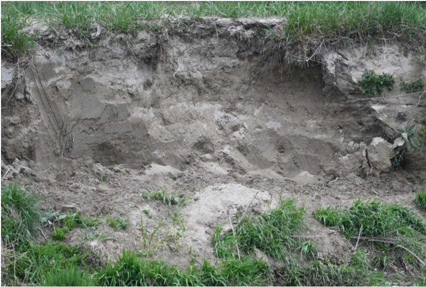
Abb. 6: Unterhalb des Schiterbergs wurde die Böschung am 18. März mit dem Bagger neu abgegraben.
