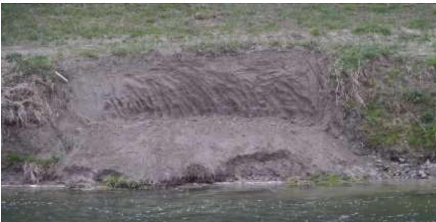
*Abb. 6: Unterhalb des Schiterbergs wurde die Böschung mit einem Bagger abgegraben. Die Prädationssicherheit könnte erhöht werden, indem die Wand bis zum mittleren Wasserstand abgegraben würde.*
