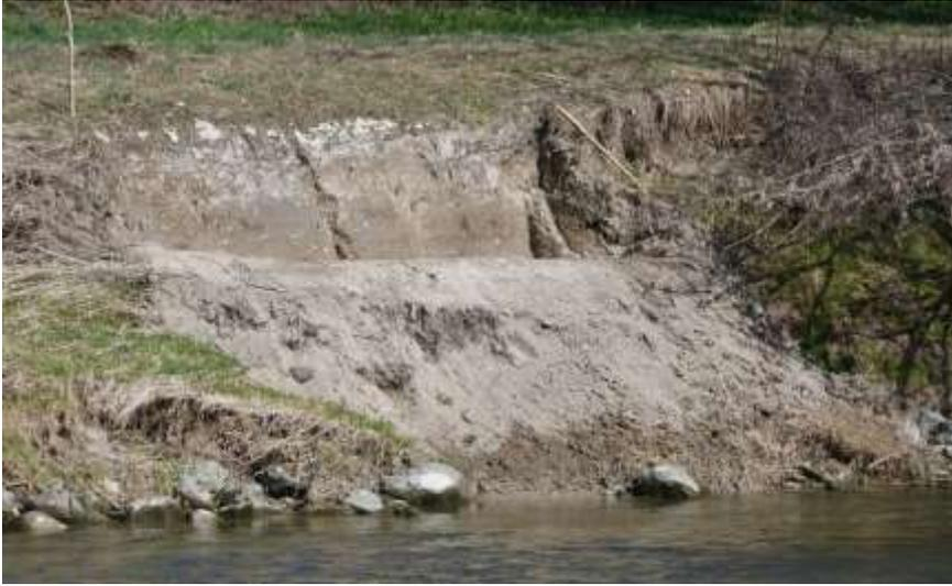
*Abb. 7: In der Au wurde diese Wand mit dem Bagger errichtet. Leider wurde sie zu wenig steil und zu wenig tief ausgeführt.*
