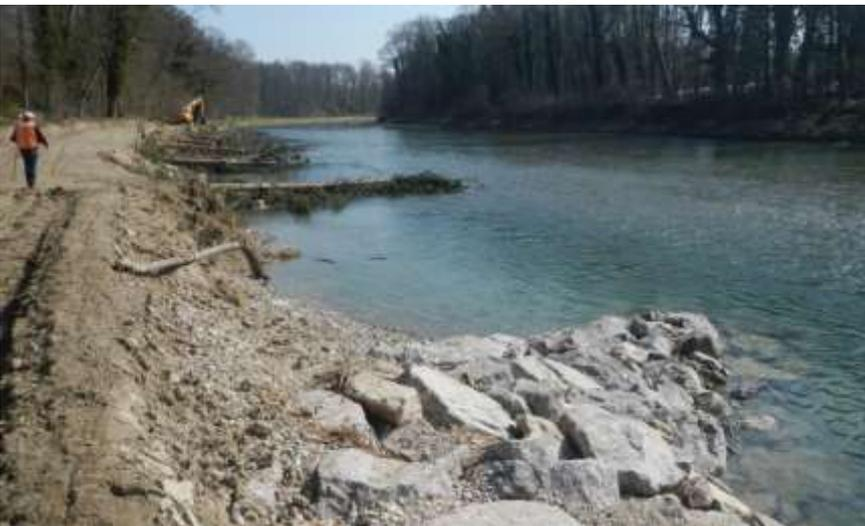
*Abb. 9: In der oberen Tüfenau wurde beim Erstellen der Holzbuhnen auch steile Uferpartien für den Eisvogel geschaffen.*
