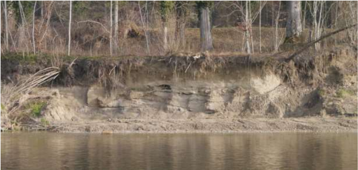
Abb. 2: Die Wand in der Wolau wurde am 16.03.2016 durch das AWEL mit Hilfe eines Schreitbaggers grosszügig abgetragen. Dabei blieb der obere Teil der Wand bestehen.
