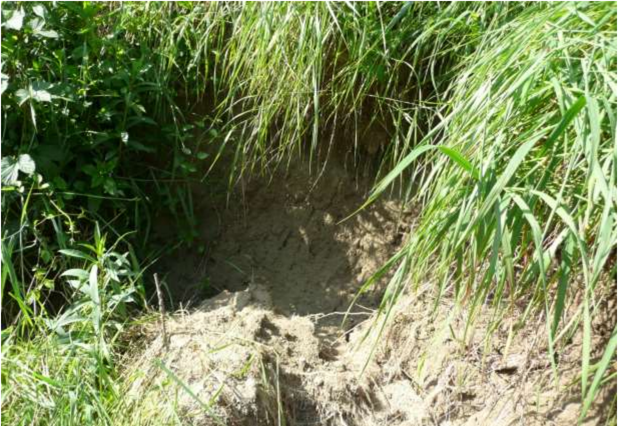
Abb. 31: Die Wand ist durch das Hochwasser von Mitte Mai mitsamt den Höhlen abgebrochen (28.05.2016).
