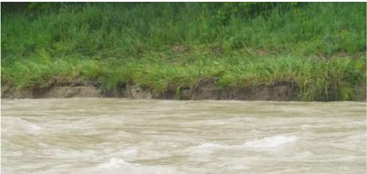
Abb. 34: Alle drei grossen Hochwasser überfluteten die ganze Abrisskante. Hier das zurückgehende Hochwasser von Mitte Mai (14.05.2016).
