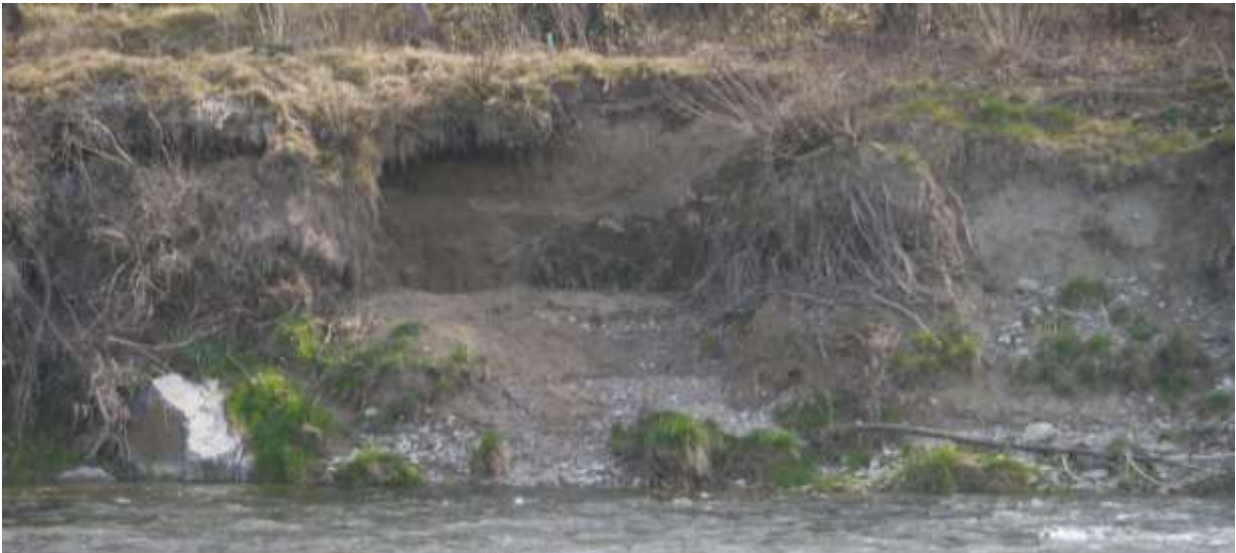
Abb. 3: Steilwand in der Wehri. Sie wurde im Herbst 2015 durch den Andelfinger Naturschutzverein neu abgestochen. Nachdem sie im Winter wieder eingestürzt war, wurde am 27.02.2016 ein Teil der Wand wieder notdürftig errichtet.
