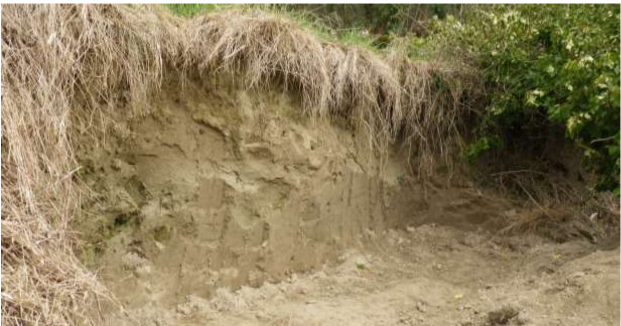
Abb. 5: Wand in der Chli Au, die am 10.03.2016 durch das AWEL wieder instand gestellt wurde. Sie wurde 2015 neu errichtet (Bild: AWEL).
