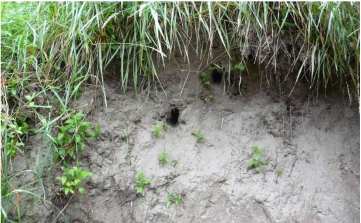
Abb. 32: Einen Monat nach behelfsmässiger Wiederherstellung der Wand sind bereits wieder zwei neue Höhlen sichtbar: unten eine fertig gestellte mögliche Bruthöhle, oben ein Höhlenanfang (25.06.2016).
