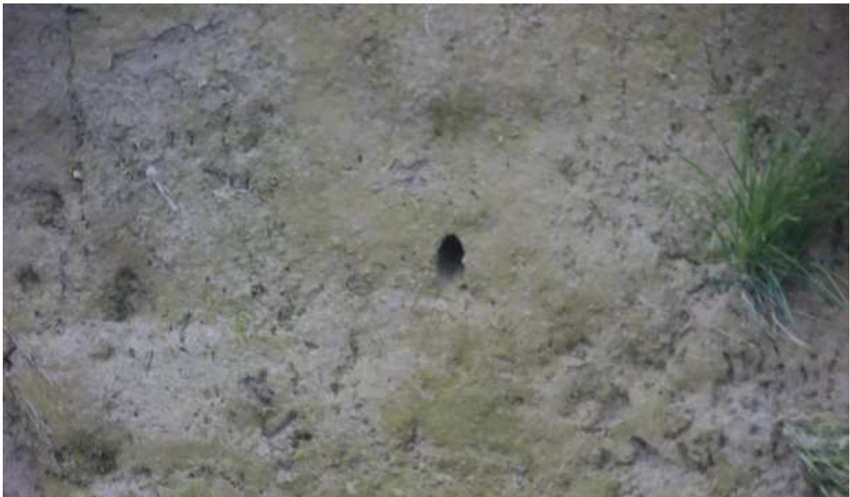
Abb. 41: Die Steilwand in der Steinegg nach dem Hochwasser (06.05.2014; Foto: Fide Meyer).
