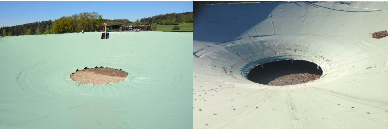
Abbildung 4: Güllelager nach der Abdeckung mittels der teilschwimmenden Folie. Links bei hohem und rechts bei niedrigem Füllstand.
