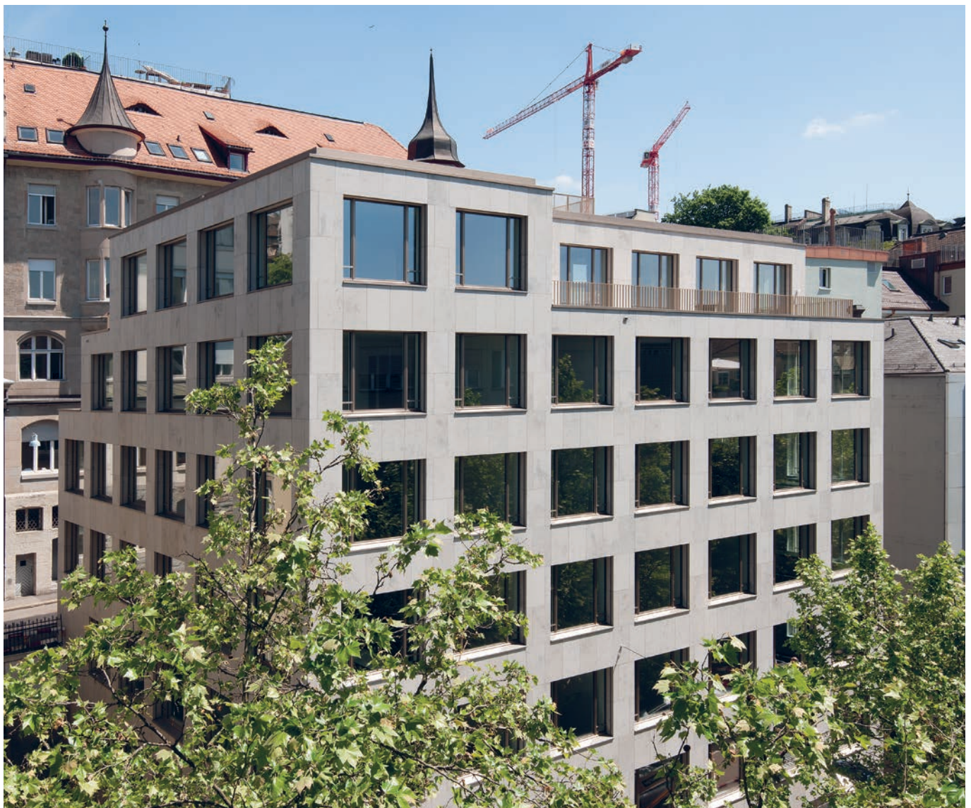
Hocheffiziente Neubauten und möglichst viele gut sanierte Bestandesbauten sind Schlüsselemente unserer Energiezukunft.
