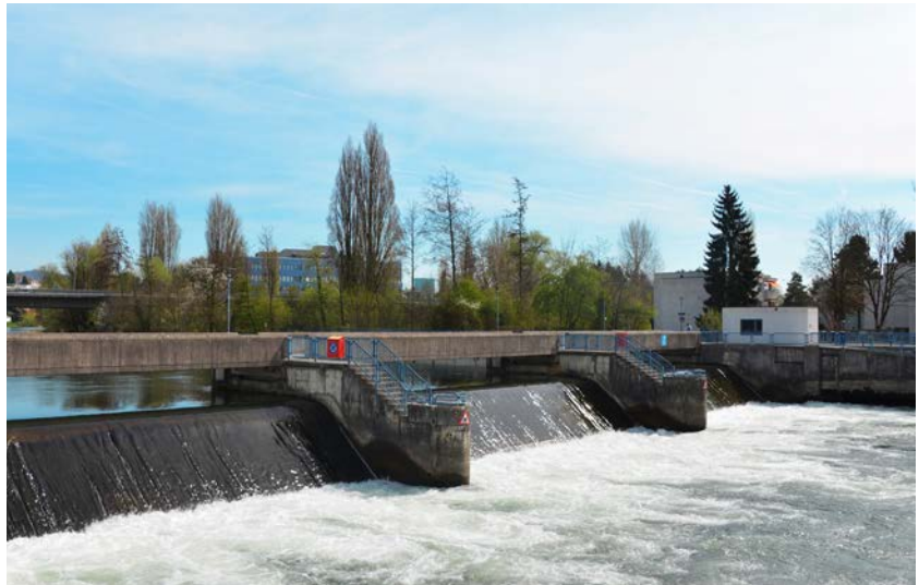
Wasserkraftwerk in der Limmat
