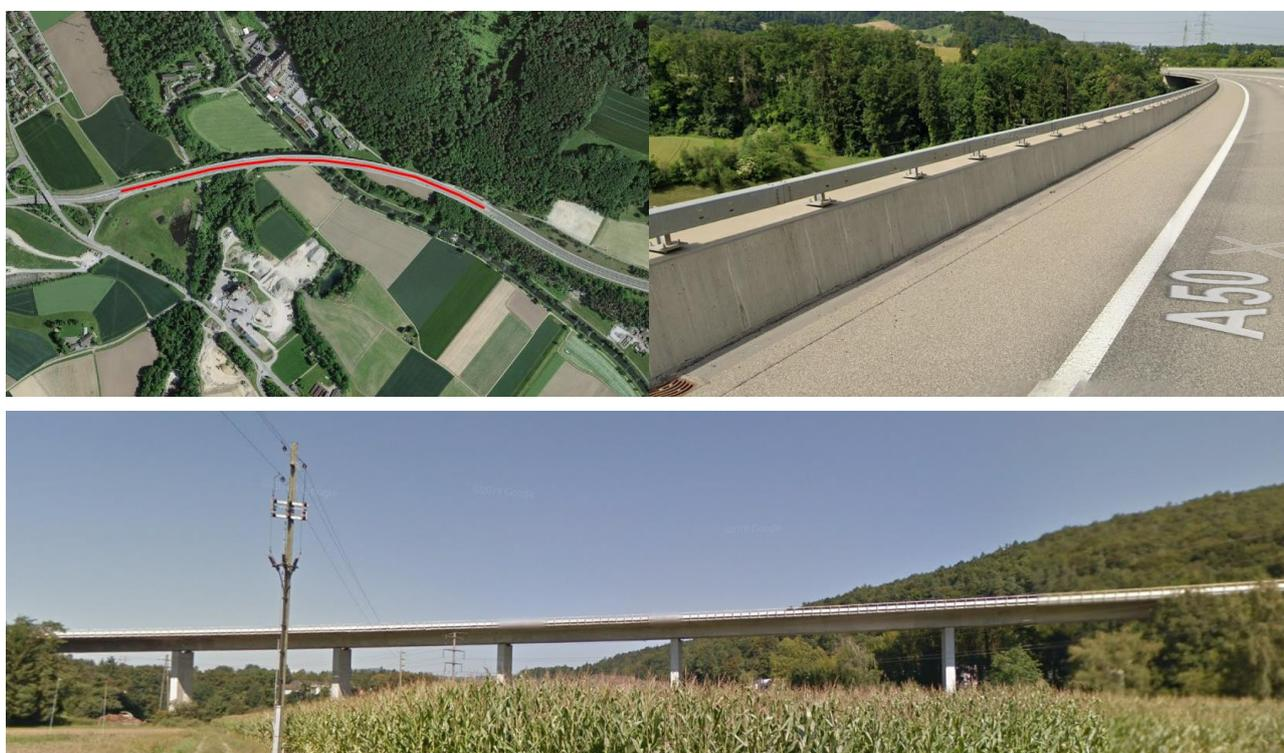
Abbildung 46: Lättenbrücke an der A50 bei Glattfelden. Satellitenbild mit rot eingezeichneter Brücke oben links (geo.admin), Ansicht von der Strasse gegen Südwesten oben rechts (Google Streetview) sowie Fernansicht aus Süden unten (Google Streetview). Die Brücke liesse eine Modulfläche von ca. 650 m<sup>2</sup> respektive eine PV-Anlage mit 130 kWp auf der Südseite der Brücke zu.
