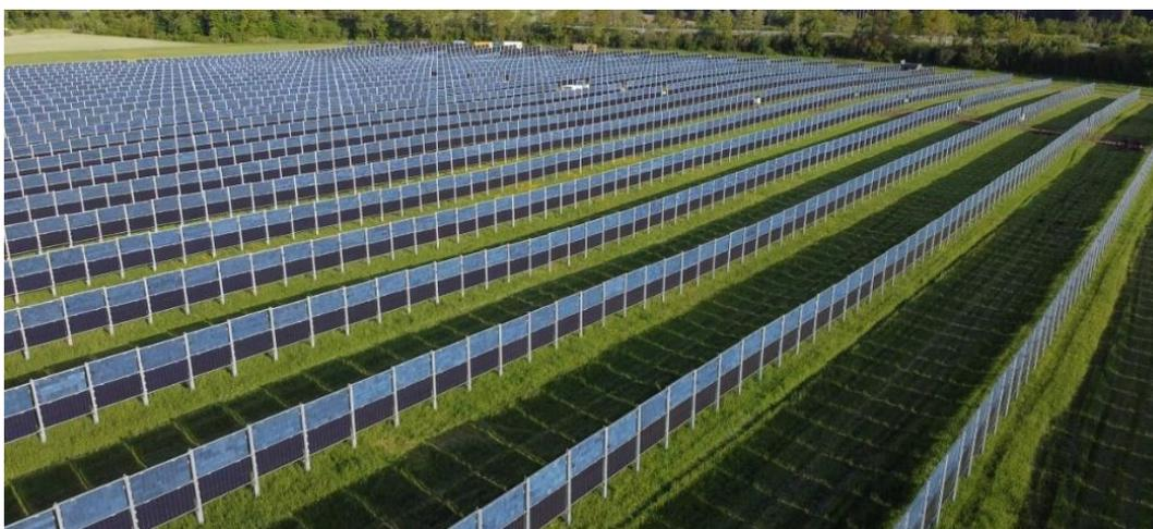
Abbildung 11: Anlagenbeispiel für Bewirtschaftungsstatus "Dauergrünland". Vertikale APV-Anlage von Next2Sun in Donaueschingen (Deutschland). Die bifazialen Module sind vertikal aufgeständert, Ausrichtung Ost-West, Reihenabstand 10 m (Next2Sun, 2020).
