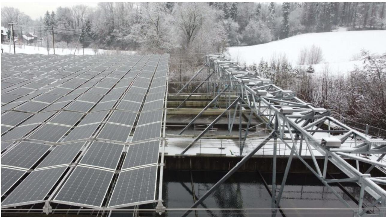
Abbildung 30: Solarfaltdächer ARA Egg-Oetwil (ZH), realisiert 2021.
