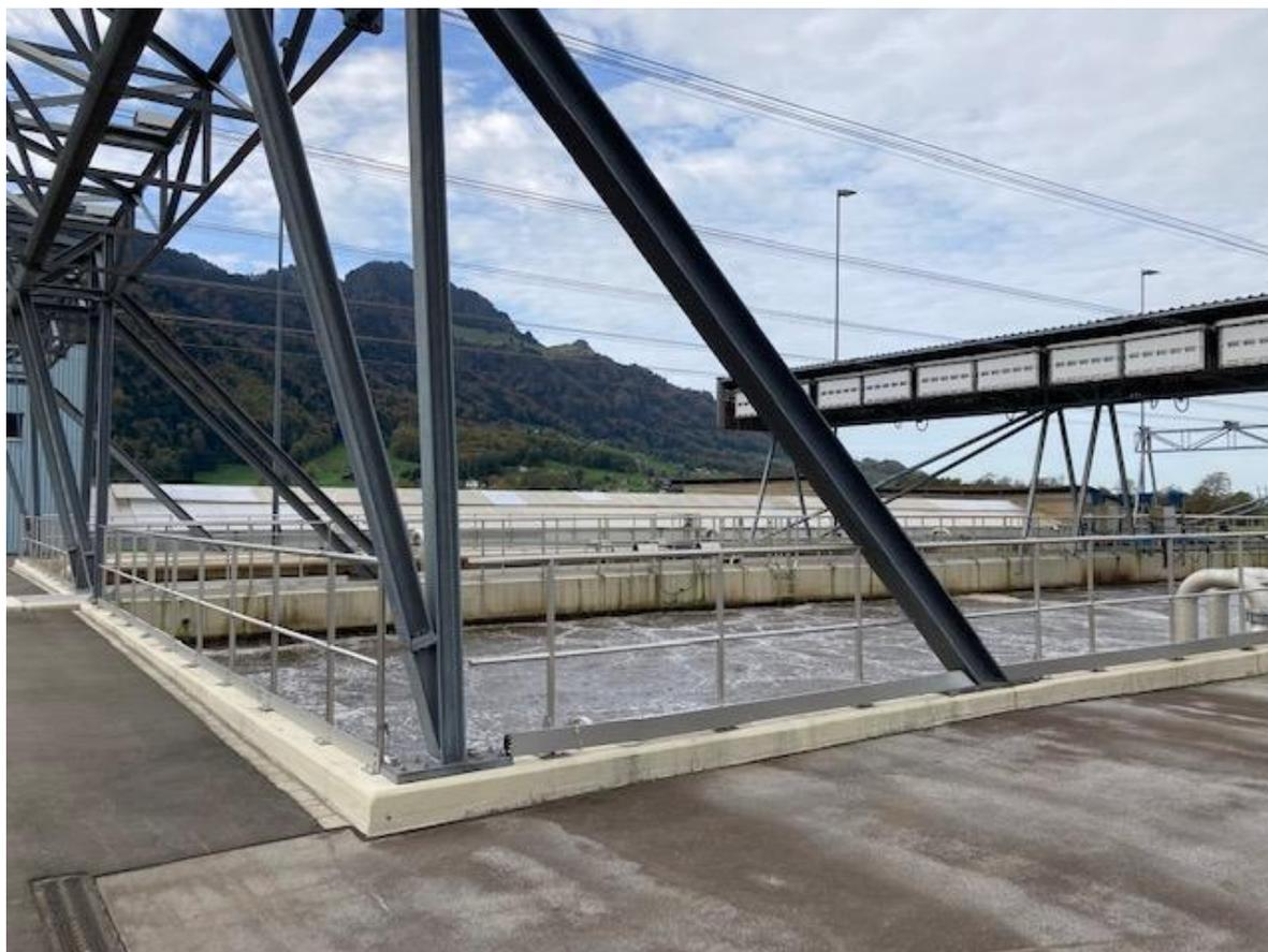
Abbildung 36: Fundament Faltdachsysteme auf Rechteckbecken. Foto ARA Glarnerland 2022.
