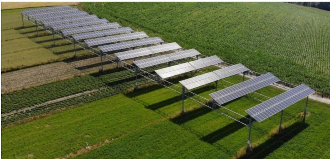
Abbildung 10: Anlagenbeispiel für Bewirtschaftungsstatus "Offene Ackerkultur". Agri-PV-Versuchsanlage (APV Resola) mit festinstallierten Modulen in Heggelbach (Deutschland). Die Module sind auf einer Höhe von 5.5 m installiert und der Stützenabstand in der Längsrichtung beträgt 19 m (Hofgemeinschaft Heggelbach, o. J.).
