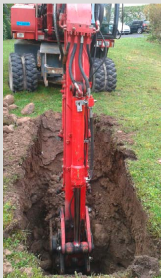
Abbildung 13: Baggersondierung
