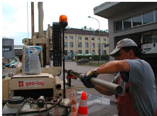
Abbildung 17: Entnahme eines Kunststoff-Liners aus der Bohrstange
