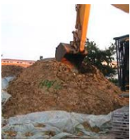
Abb. 4a Bagger, Radlader
