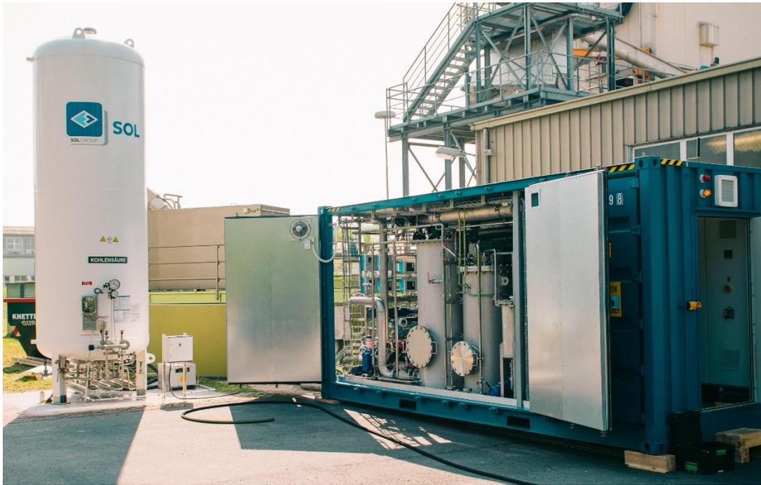
**Abbildung 2: ExtraPhos®-Pilotanlage und CO<sub>2</sub>-Tank an der Kläranlage Mainz-Mombach**
